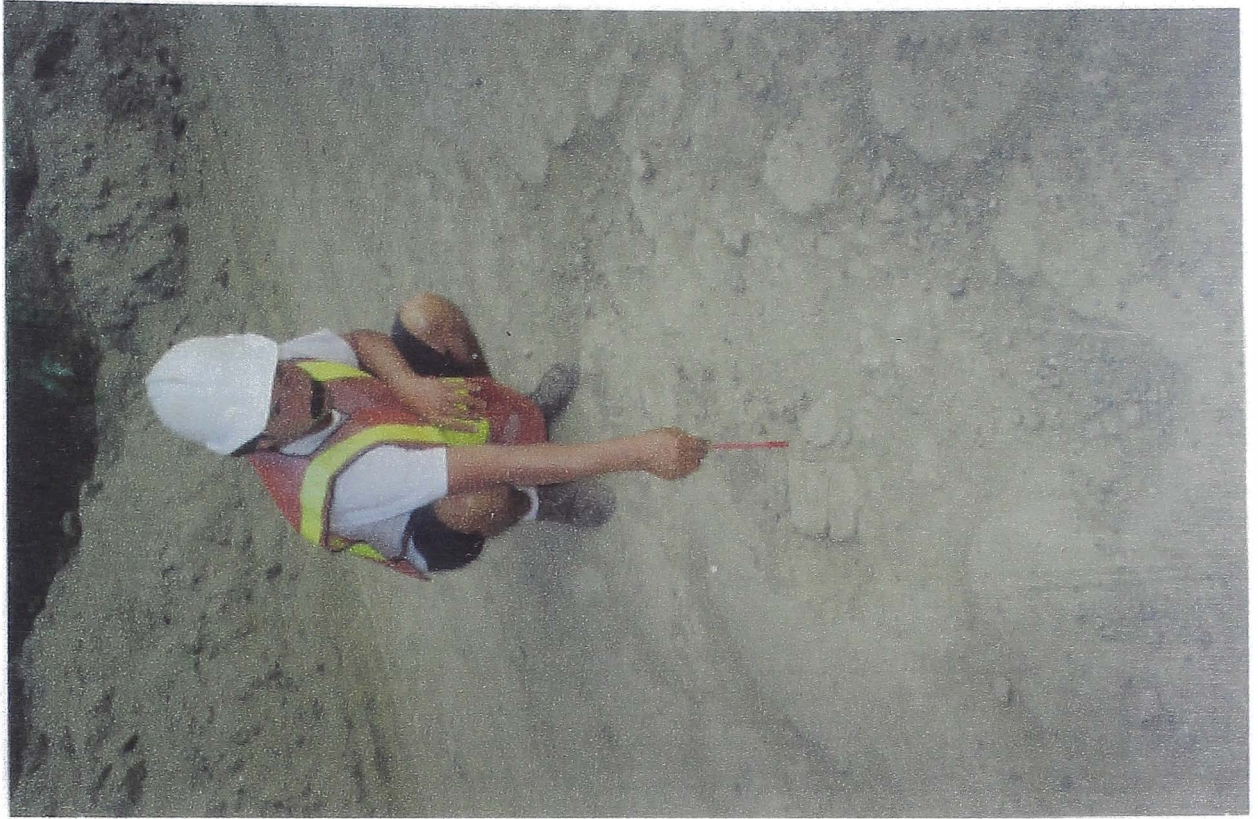
FOTO N° 07 Baches, secciones de la vía sin carpeta producto del Huayco.
