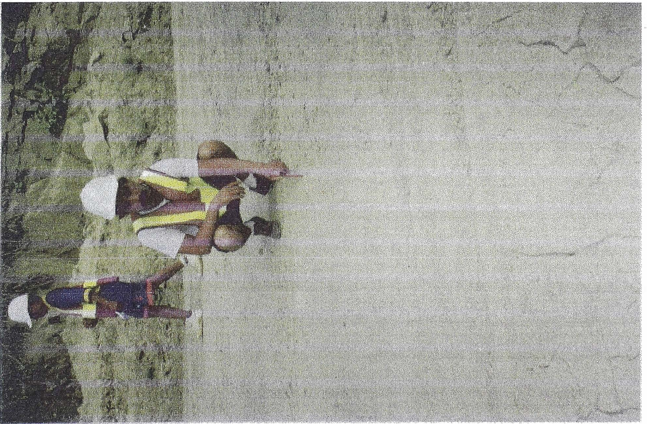
FOTO N° 05 Carpeta completamente disgregado.
