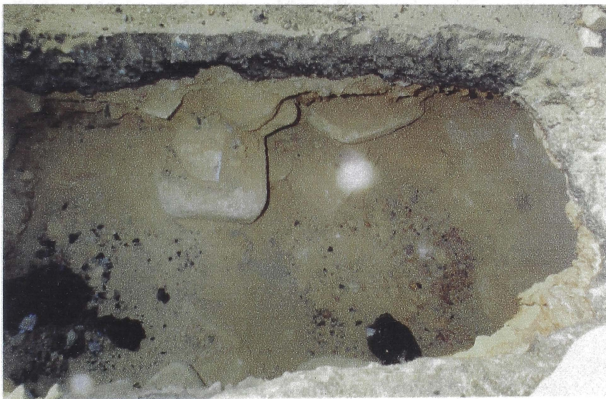
FOTO N° 20 Calicata con una sola capa y con rocas de gran tamaño.
