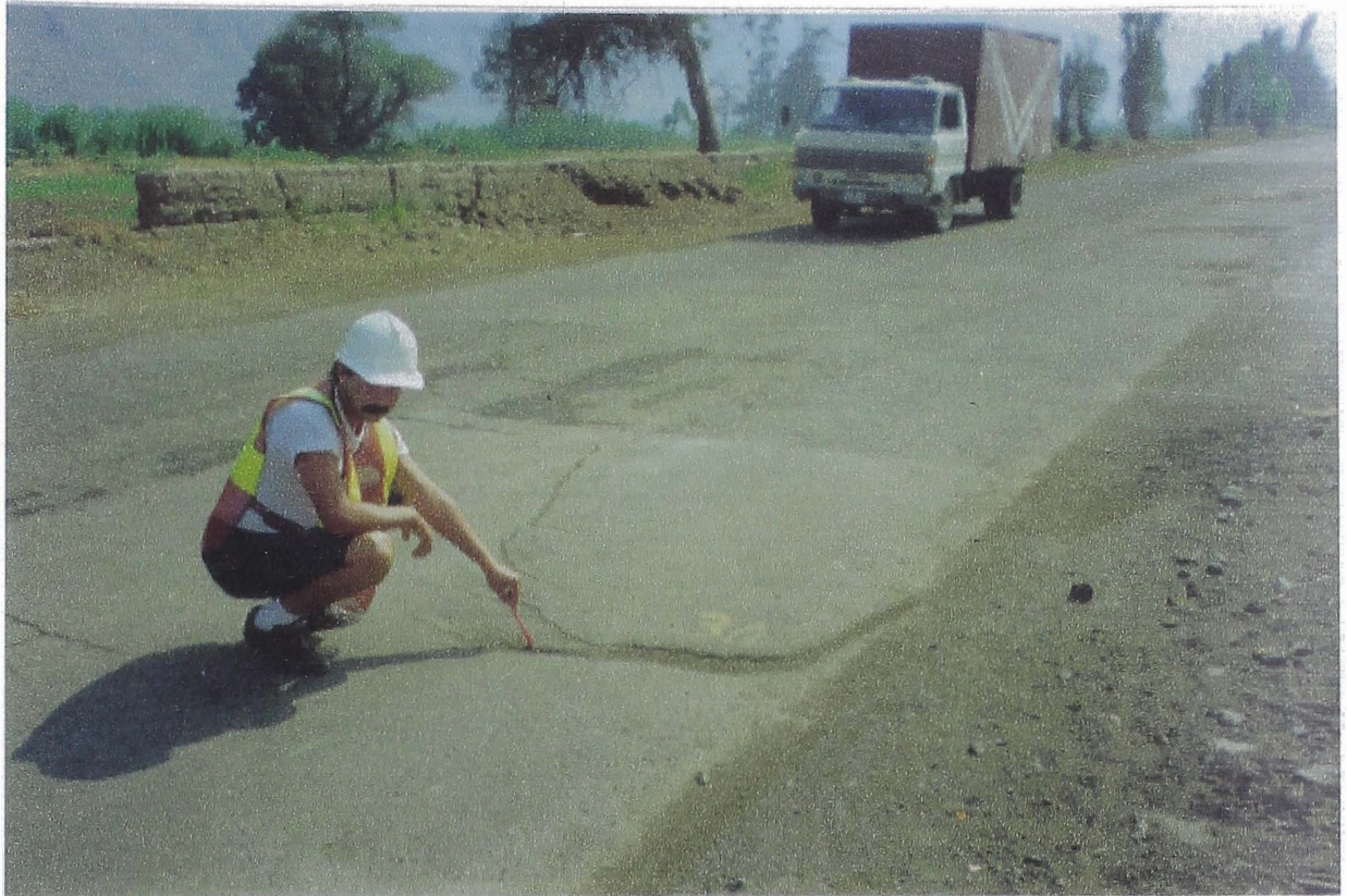
FOTO N° 09 Falla Transversal y Longitudinal, aparentemente reflejada en parche sobre vía rehabilitada.
