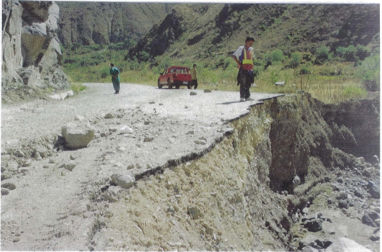
FOTO N° 25 Socavación del terraplén de la vía por efecto de la crecida del río Chillón. Nótese los espesores de las capas conformantes del Pavimento.
