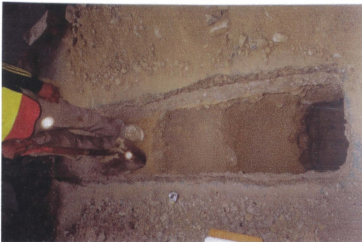
FOTO N° 19 Calicata, en forma escalonada por cada capa que conforma el pavimento.
