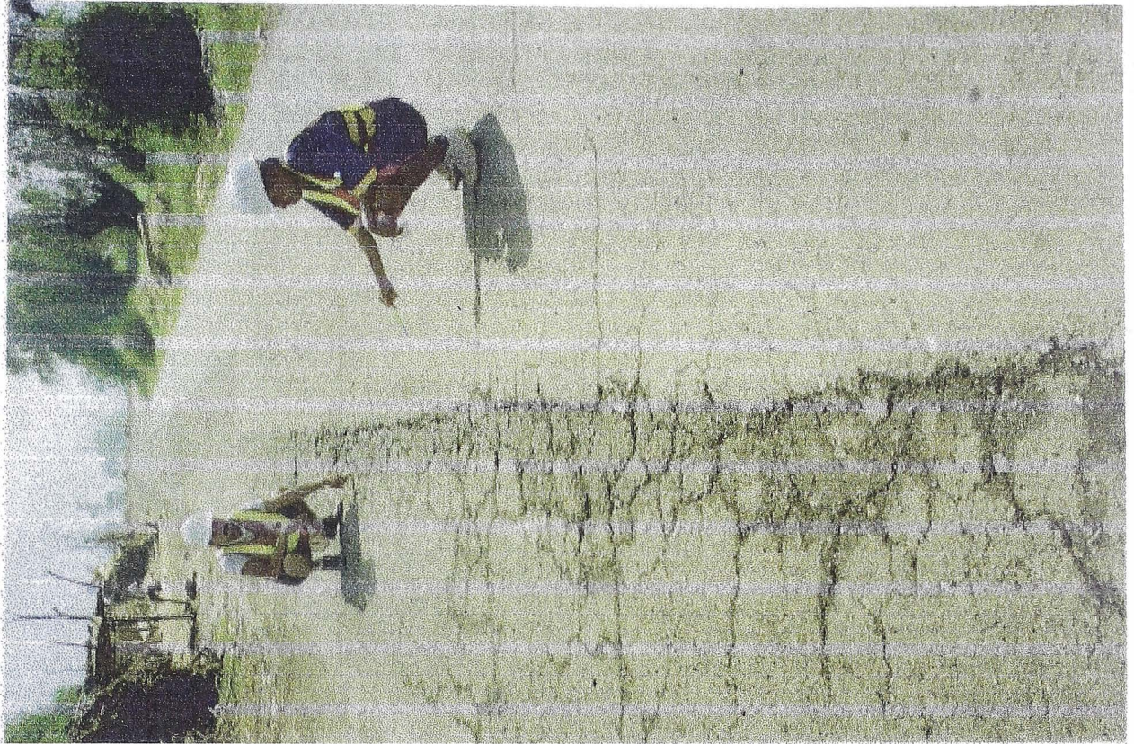
FOTO N° 03 Falla tipo Piel de Cocodrilo, combinadas con fallas Transversales que llegan hasta la Base del Pavimento.
