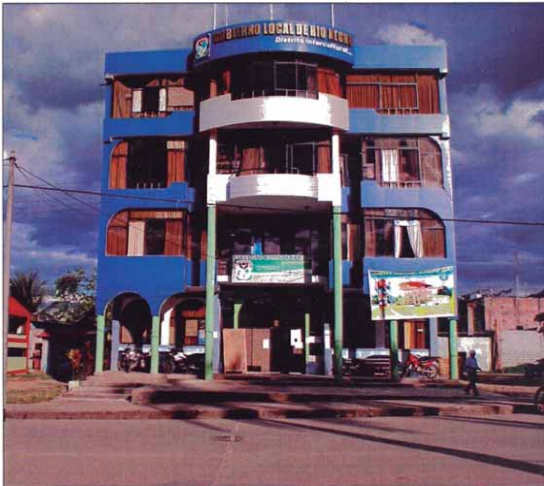
Figura No 3.1.- Vista del edificio municipal del distrito de Río Negro
