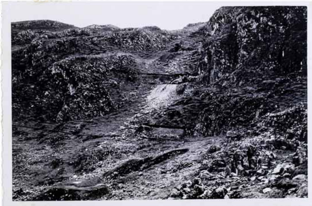
Zona del Nivel N° 4
