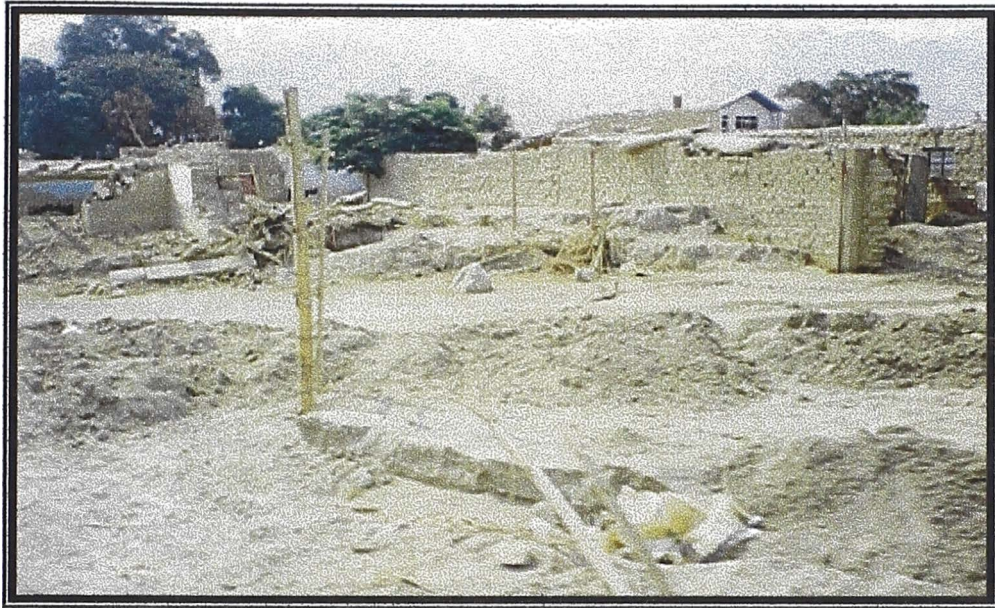
FOTO N° 03: Distrito Los Molinos. Viviendas de adobe que han sido destruidas en el huaico. Agosto de 1998
