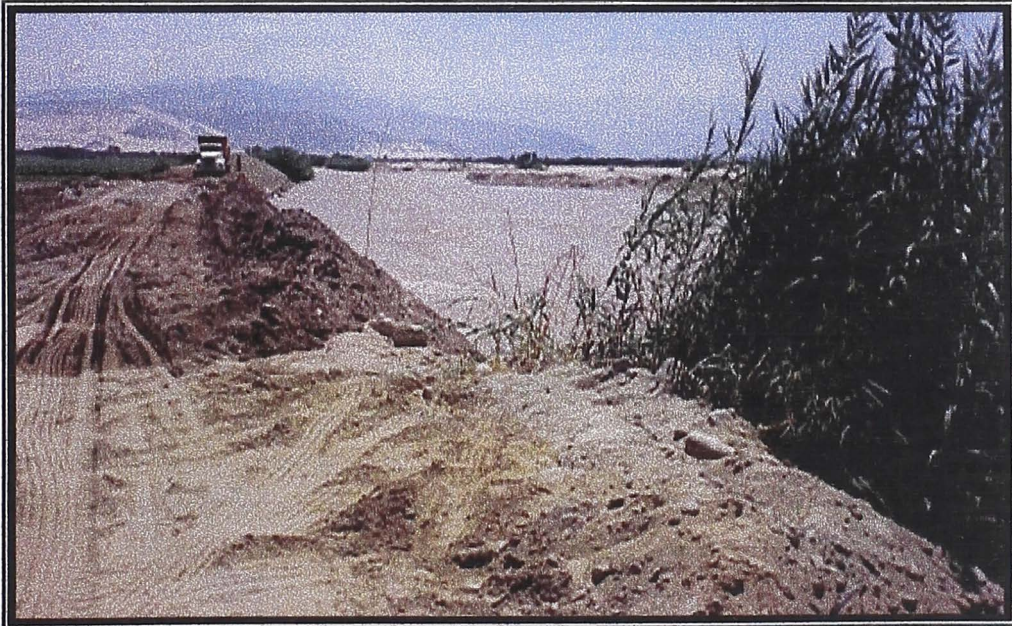
FOTO N° 10: Zona de San Juan. Protección temporal de la margen derecha del río Ica. Marzo de 1999
