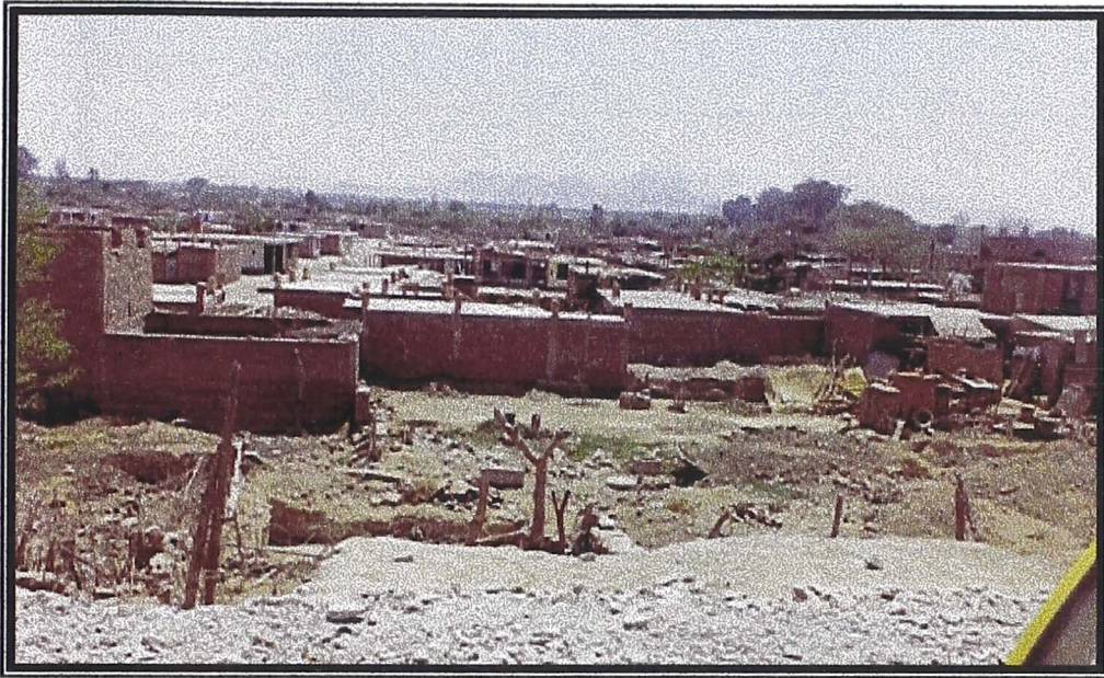
FOTO N° 23: Margen izquierda. Viviendas de ladrillo reemplazando a las de adobe, después del desastre de 1998
