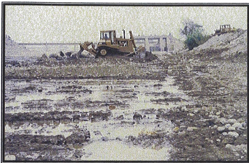
FOTO N° 05: Bocatoma La Achirana. Daños causados por el evento ocurrido en Enero de 1998
