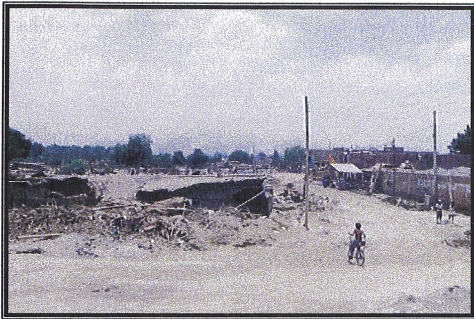
FOTO N° 21: Margen izquierda del río. Viviendas de adobe destruidas. Agosto de 1998
