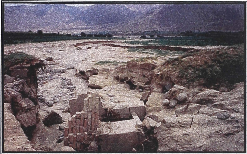
FOTO N° 09: Zona de Trapiche. Vivienda destruída por los huaicos en la quebrada. Marzo de 1999
