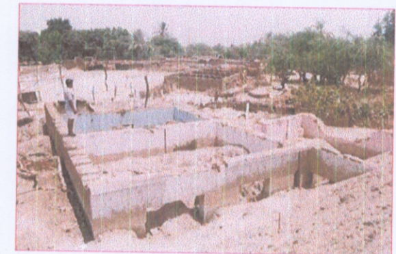
VIVIENDA ENTERRADA POR HUAYCO CASERIO CHANCHAJALLA ENERO-1998
