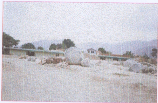
POSTA MEDICA ENTERRADA POR HUAYCO SAN JOSE DE LOS MOLINOS ENERO-1998
