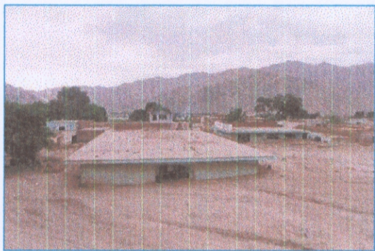
VIVIENDAS COLMATADAS CON MATERIAL FINO, LOS MOLINOS - ENERO DE 1998
