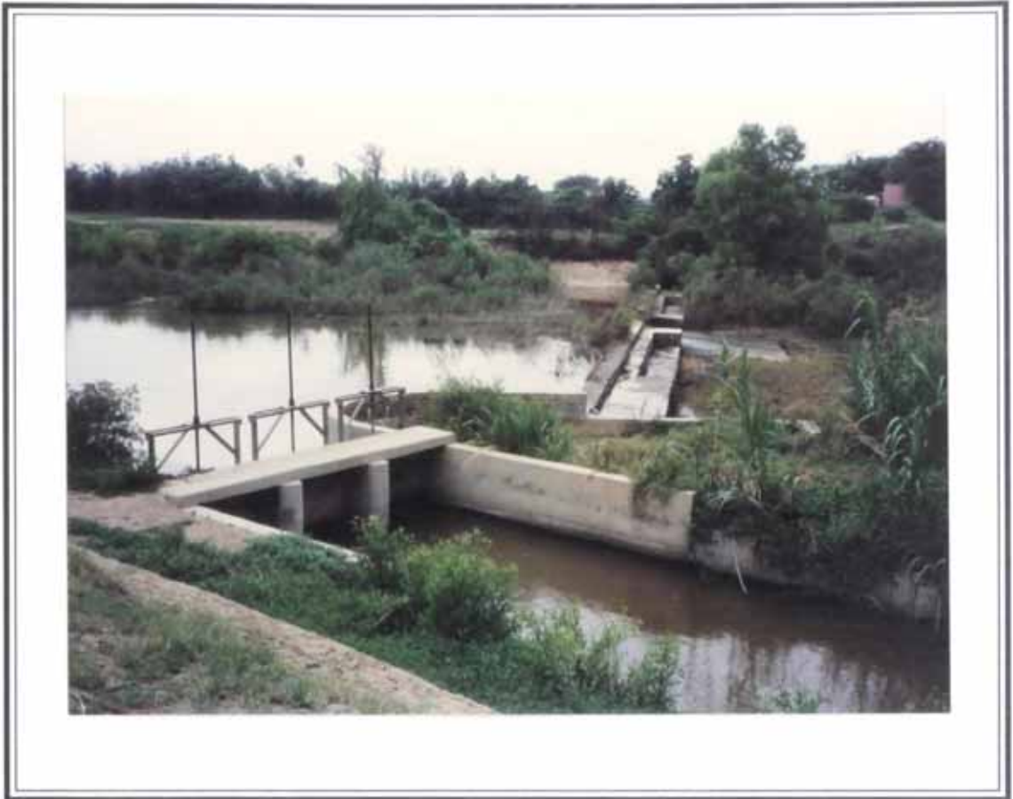
Foto 10.-Estructuras de Captación y Derivación en el río Zaña.
