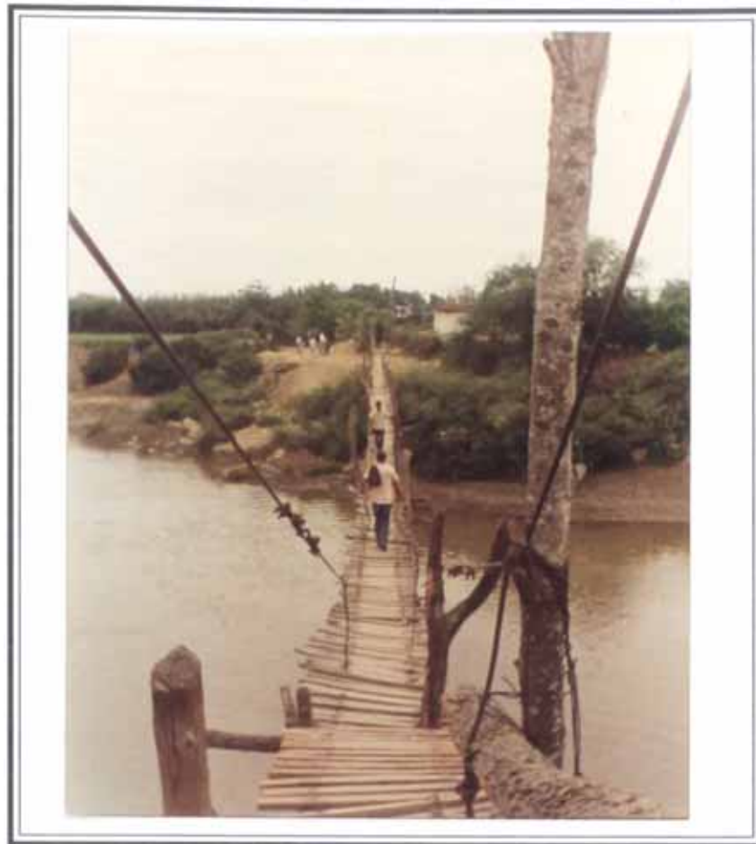
Foto 14: Puente colgante sobre el río Zaña.
