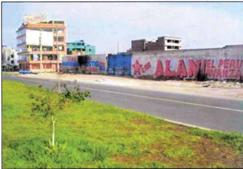
Figura 1.3: Terreno cercado con acceso por la Av. Tomás Valle
