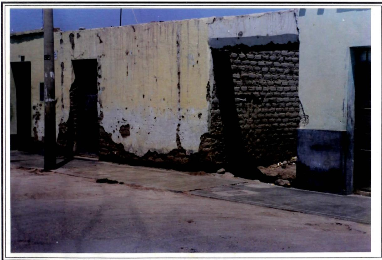
Foto N°21 : Otra vista de una vivienda en el barrio de San Carlos en la que se aprecia el grado de deterioro de la misma. Se observa además la acción de la humedad sobre la parte baja del muro, al igual que la fotografía anterior.
