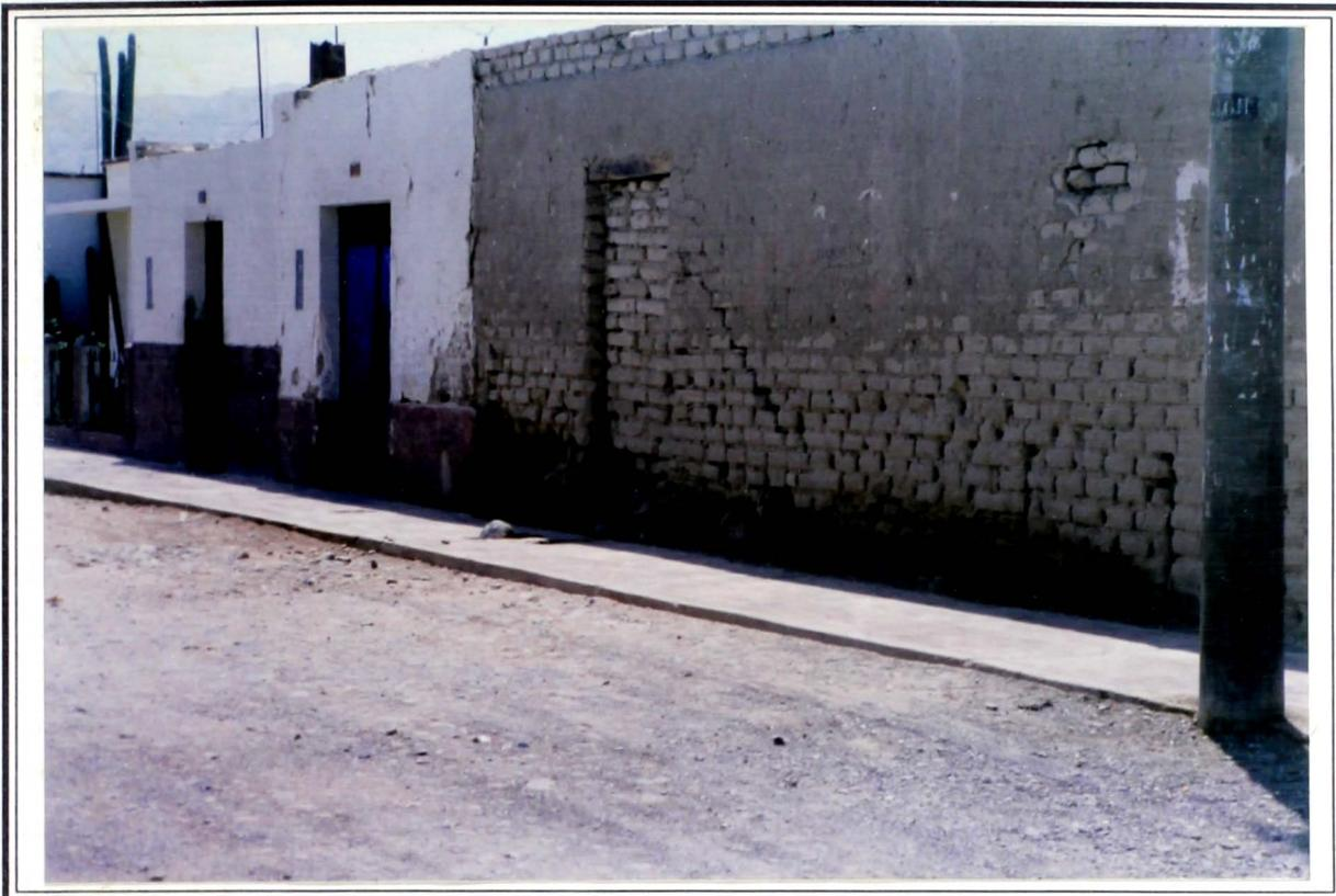
Foto N°20 : Fotografía tomada en el barrio de San Carlos. Se observa que la humedad ha carcomido la parte baja del muro de adobe lo cual va a hacer que muy pronto el muro colapse. Se observa ya una rajadura que corre en forma diagonal.
