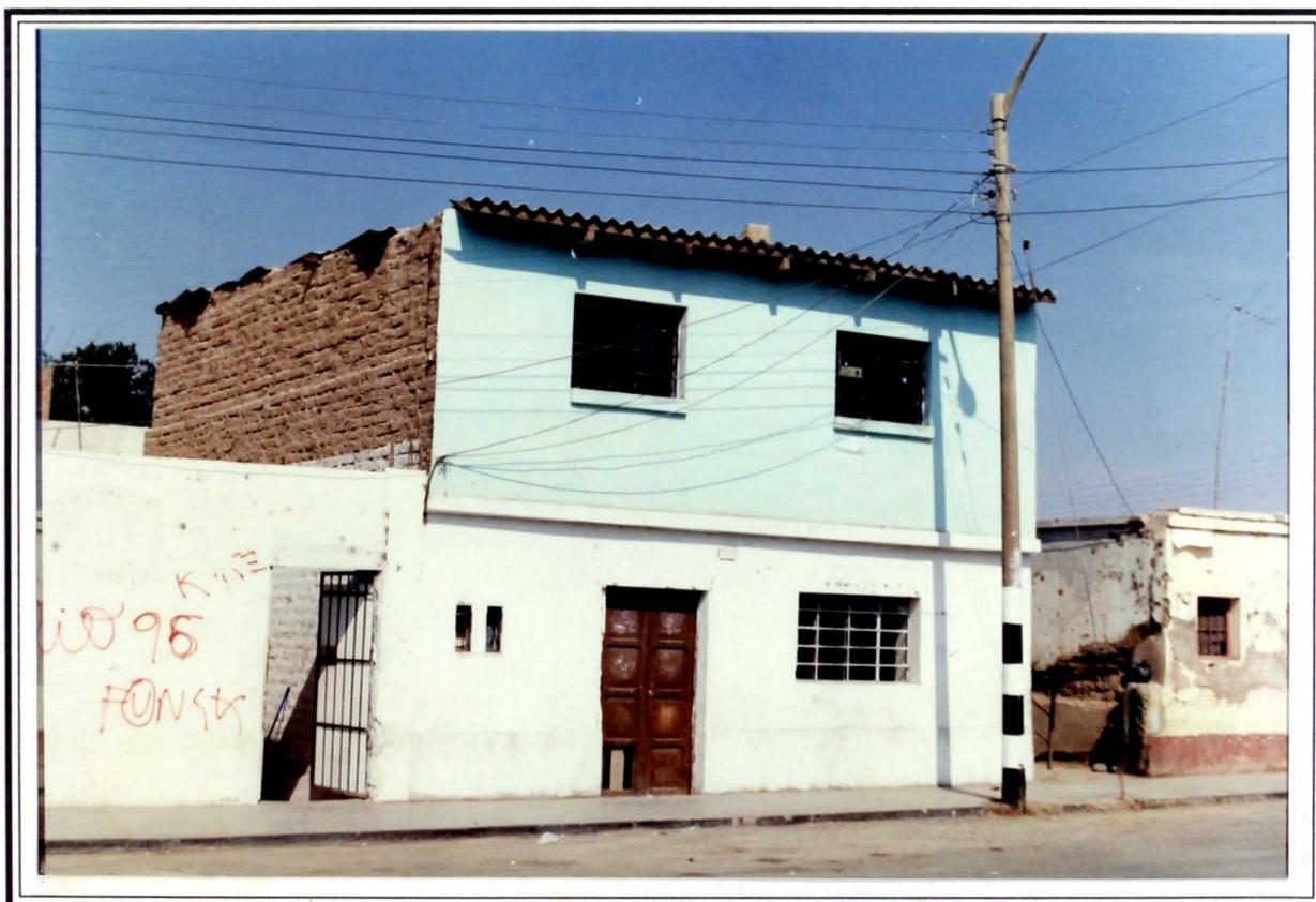
Foto N°23 : Fotografía tomada en el Jr. Arica en la zona central de Nasca. Se observa una construcción de ladrillo en segunda planta sobre una de adobe en primer piso. La ampliación de ladrillo en el segundo piso carece de columnas.
