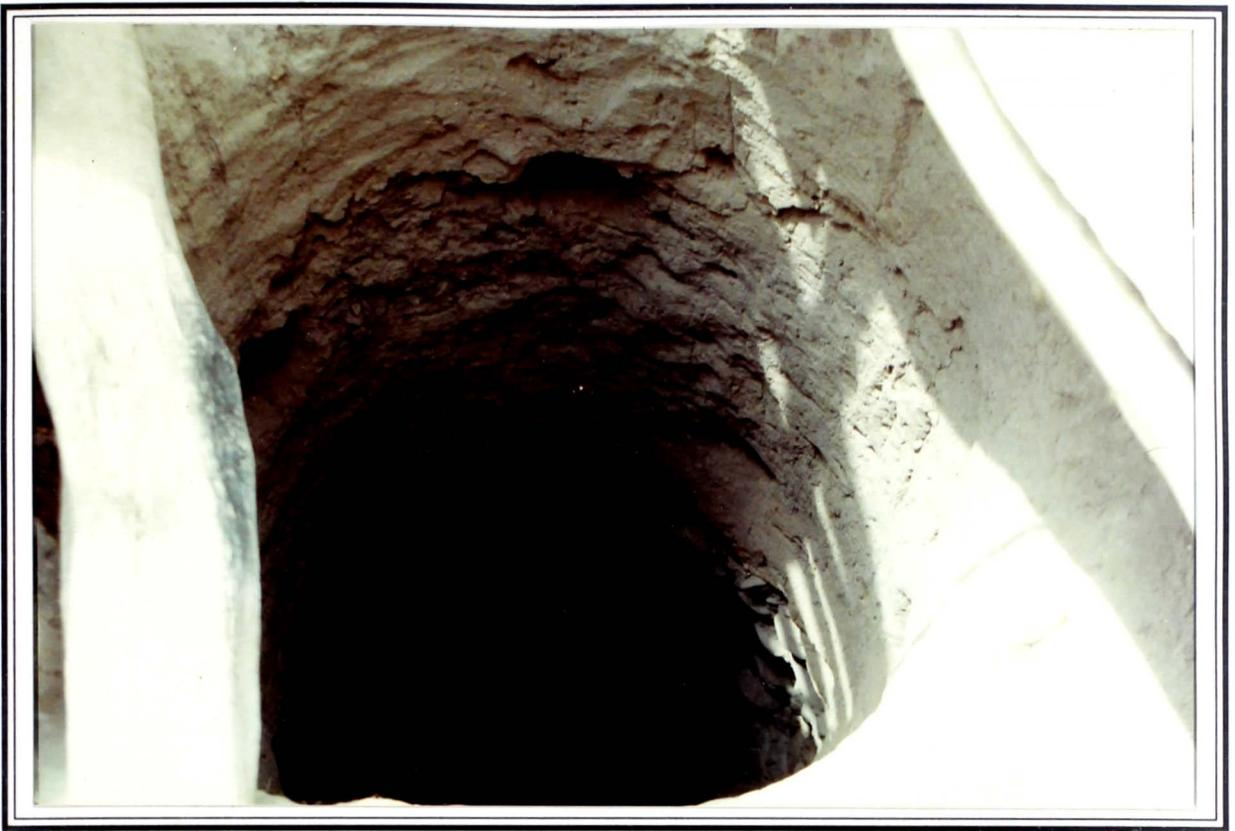
**Foto N°4** Vista de un pozo a tajo abierto ubicado en la zona de Bizambra. Se observa el perfil característico de los suelos de Nasca: Un primer estrato de arcillas y limos con un espesor de 0.80 a 2.00 mts. seguido por un estrato de conglomerado de gravas y guijarros, que se extiende hasta los 10 a 15 mts.
