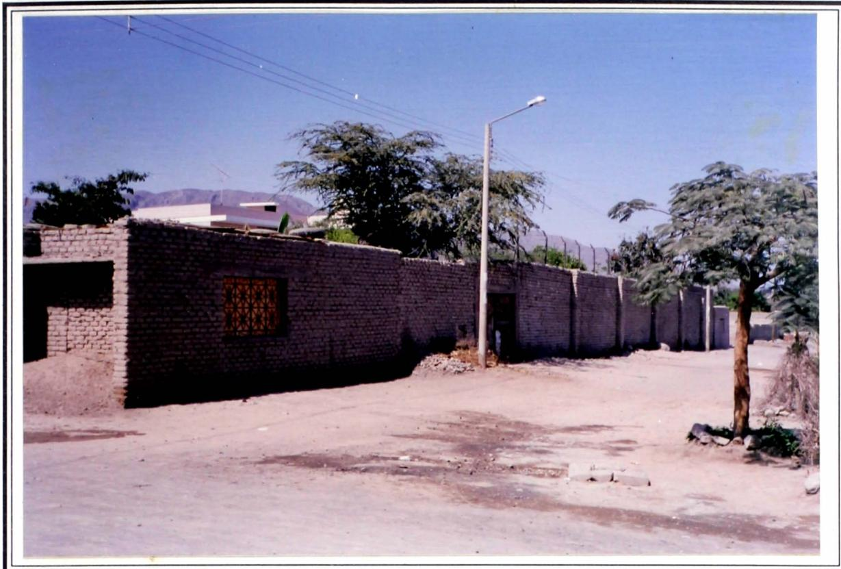
Foto N°22 : Fotografía tomada en el barrio de "El Porvenir" en el distrito de Vista Alegre. Se muestra un defecto típico de construcción en la vivienda de adobe: muros excesivamente largos, sin columnas o mochetas que le den confinamiento y ausencia de viga collar que distribuya uniformemente la carga vertical.
