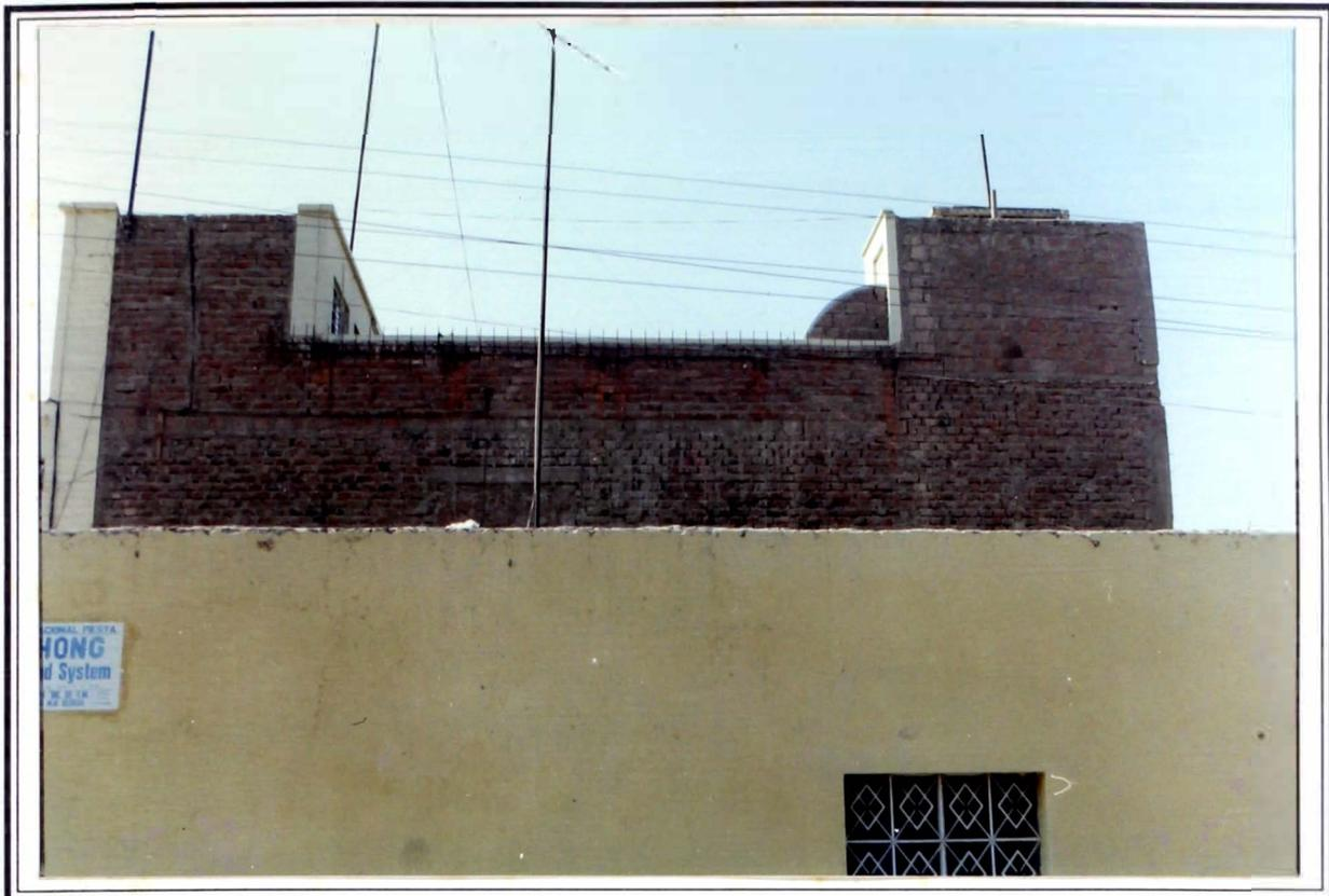
Foto N°24 : Vista lateral desde el Jr. Fermín del Castillo de una vivienda en el Jr. Arica. Se puede apreciar la ausencia de columnas de confinamiento así como la presencia de unidades de albañilería de diferentes calidades y tamaños.
