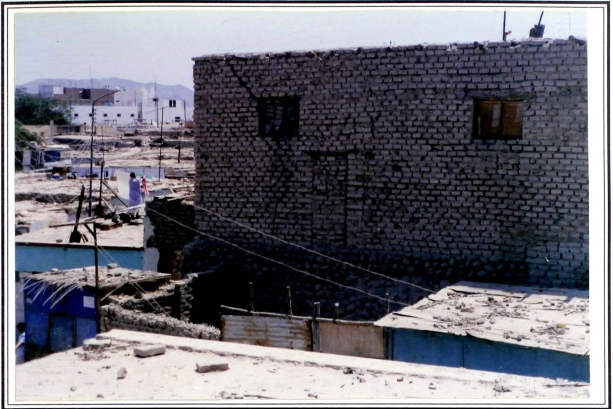
Foto N°18 : Vivienda ubicada a la altura de el puente del Jr. Arica. Se observó una enorme grieta diagonal que parte del vano de la ventana lateral y se extiende hacia abajo y hacia arriba del muro, llegando hasta el techo.
