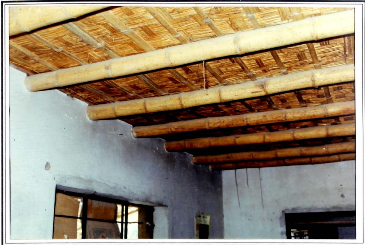
Foto Nº16 : Techado típico de las viviendas tipo I. Entramado de caña Guayaquil y cobertura de esteras de bambú o caña partida y encima de estas: una torta de barro.
