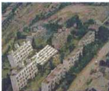
Foto N° 2 : Los edificios de departamentos de Kawagishi – cho, sufrieron fallas en la capacidad de soporte, 1964.
