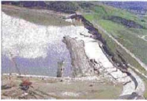
Foto N° 16 : Deslizamiento en la presa de San Fernando, sismo de 1971.
