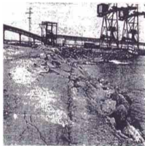
Foto N° 14 : Agrietamiento del terreno en la llanura aluvial del Río Lacramarca. Foto N° 15: Daño en el Puerto de Chimbote. Derrumbe del camino pavimentado.
