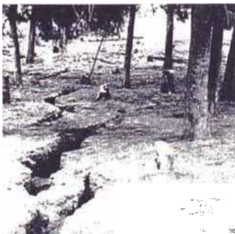
Foto N° 14 : Agrietamiento del terreno en la llanura aluvial del Río Lacramarca. Foto N° 15: Daño en el Puerto de Chimbote. Derrumbe del camino pavimentado.
