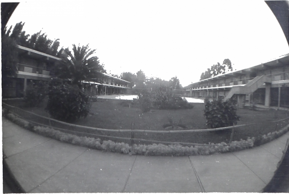
Foto No 13 : COLEGIO PIO XII. VISTA PANORAMICA DE AMBOS PABELLONES.
