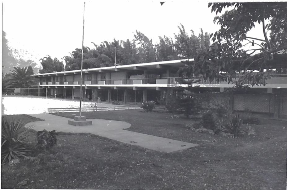
Foto No 14 : COLEGIO PIO XII. VISTA DEL PABELLON DAÑADO.
