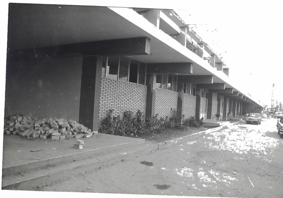
FOTO Nº 22 : COLEGIO RECOLETA, FALLA POR COLUMNAS CORTAS.
