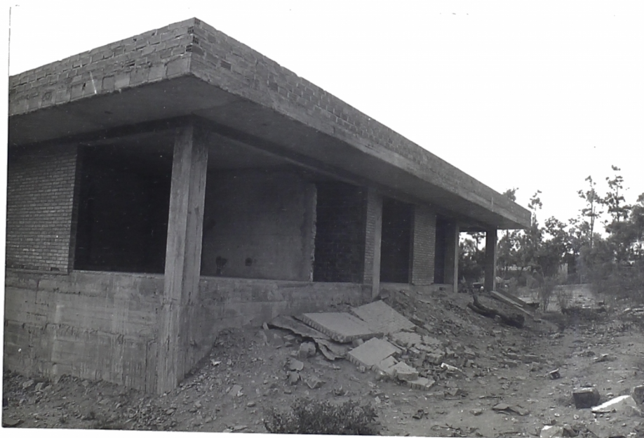
Foto No 4 : TABIQUERIA FLOTANTE EN CASUARINAS.
