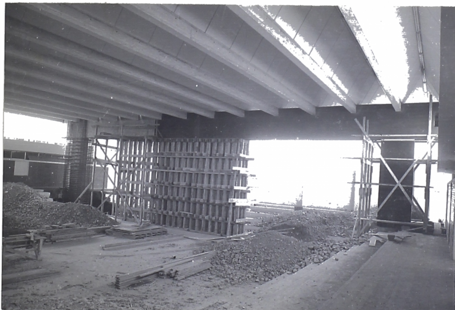
Foto No 10 : TRABAJO DE REPARACION, REFORZAMIENTO Y APUNTALAMIENTO DE LA VIGA.
