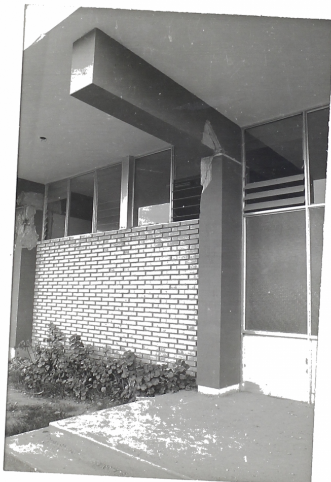
FOTO Nº 22 : COLEGIO RECOLETA, FALLA POR COLUMNAS CORTAS.
