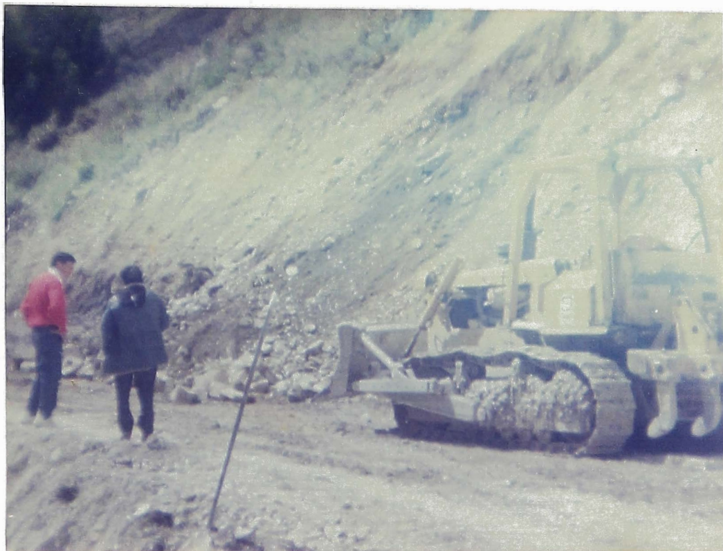
FOTO N o 07.- Vista de los Huaycos que interrumpen el paso de vehículos. Estos se producen entre Vilcacoto y Chamicería por tener laderas erosionables. Falta un programa de reforestación de laderas. (Ene 93)
