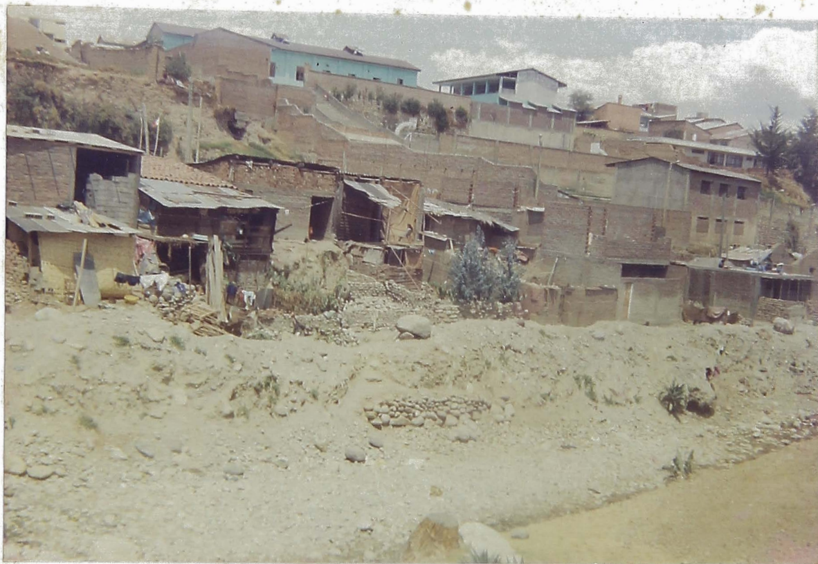
FOTO Nº 09.- Vista del Asentamiento humano Santa Rosa, muestra la zona que sufrió el desastre, las casas se levantan con material noble y de adobe, sin ningún tipo de protección, hoy es zona vulnerable a inundaciones (Ene 93)
