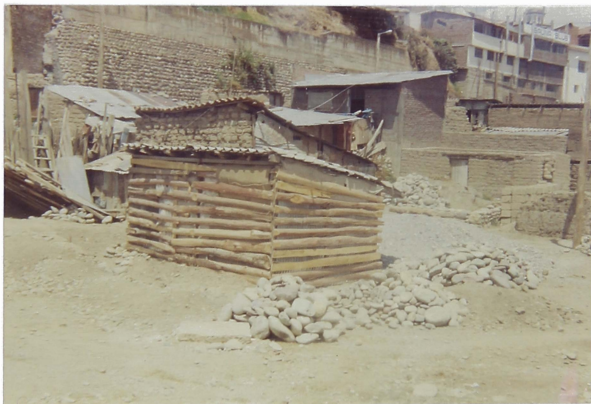
FOTO Nº 18.- Aquí se aprecia otro tipo de construcción con adobones, estos hogares están prácticamente ya reconstruidos porque el aluvión llegó hasta el nivel del techo de los hogares que se aprecia (zona de vulnerabilidad AA.HH. Santa Rosa). (Agosto 92).
