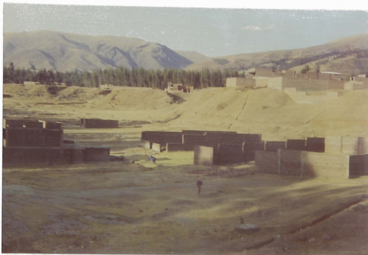
FOTO Nº 11.- Vista del Barrio Centenario, . obsérvese que esta construyendo en una zona plana y de material noble ubicado en la margen izquierda del río Shullcas, este lugar también esta dentro de las zonas de peligro a aluviones (Agosto - 92).
