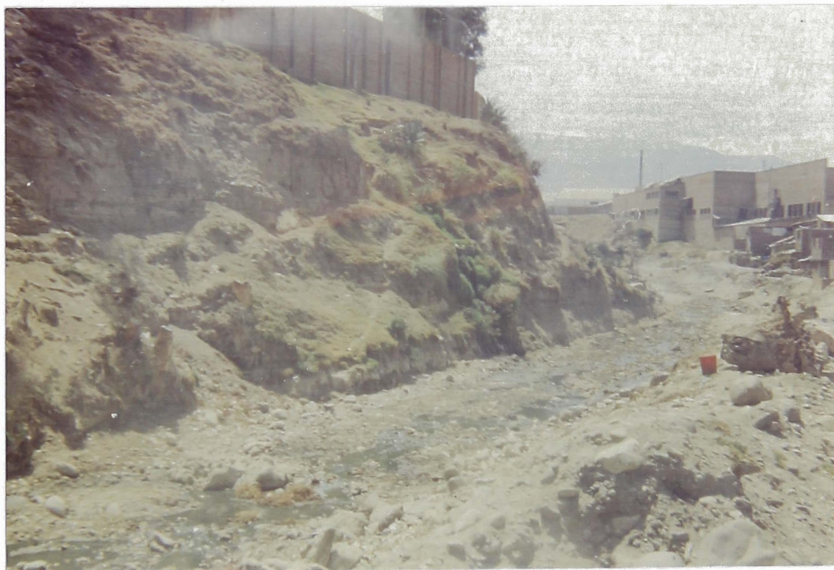
FOTO Nº 16.- Vista del curso del río aguas arriba del Asentamiento Humano Santa Rosa, nótese la curva del río fue la que inundó y destruyó las casas del lugar. (Agosto 92) (época de estiaje).
