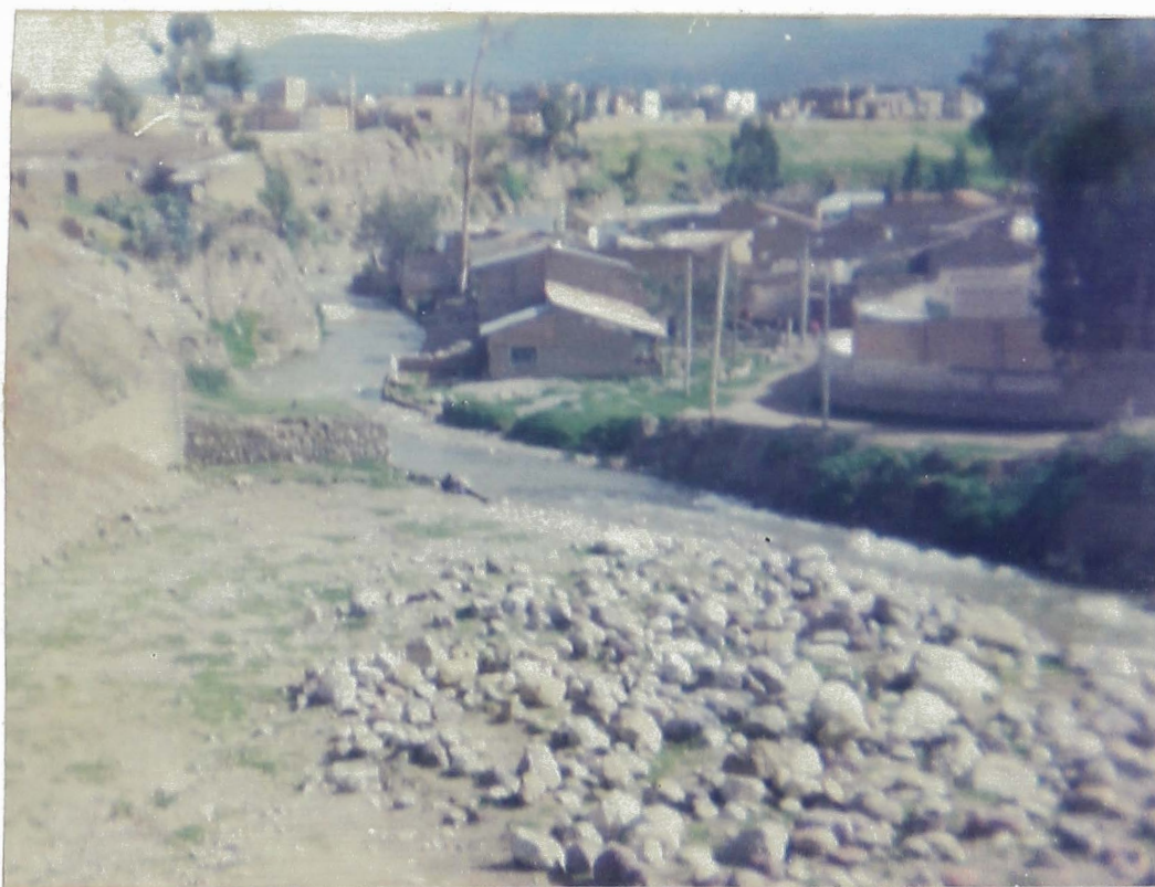
FOTO Nº 12.- Vista del Barrio Salcedo, en la toma se aprecia el curso del Río, el Agua viene de bajada a la foto, entonces todas las casas que se observa están expuestas a riesgos de desastres aluviónicos, es necesario reubicarlos o crearse sistemas de protección.
