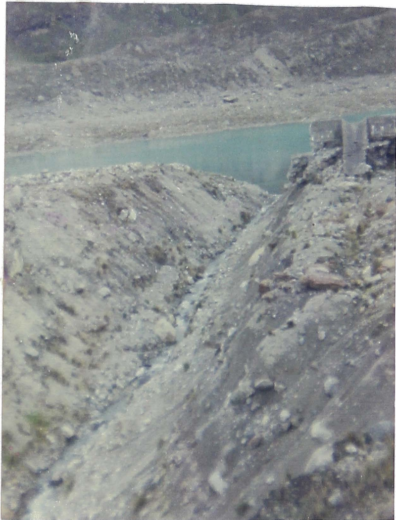
FOTO N o 04.- Vista del dique morrénico frontal de la Laguna Lasuntay, actualmente se encuentra en esta situación, este fue destruido por el aluvión del año 69, la morfología de la laguna a cambiado podemos apreciar el nivel que descendió. El espejo de la laguna y el muro de encausamiento destruido, solo se ve un resto en la parte derecha.
