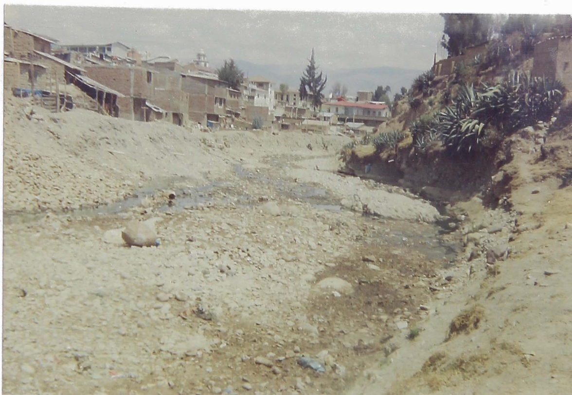
FOTO Nº 15.- Vista del Asentamiento Humano Santa Rosa en pleno centro de la ciudad (izquierda) (zona de vulnerabilidad) obsérvese que las casas están cerca al curso del río y sin ningún tipo de protección, y a la derecha se observa algunas casas que están protegidos por el pequeño cerro. (agosto 92).
