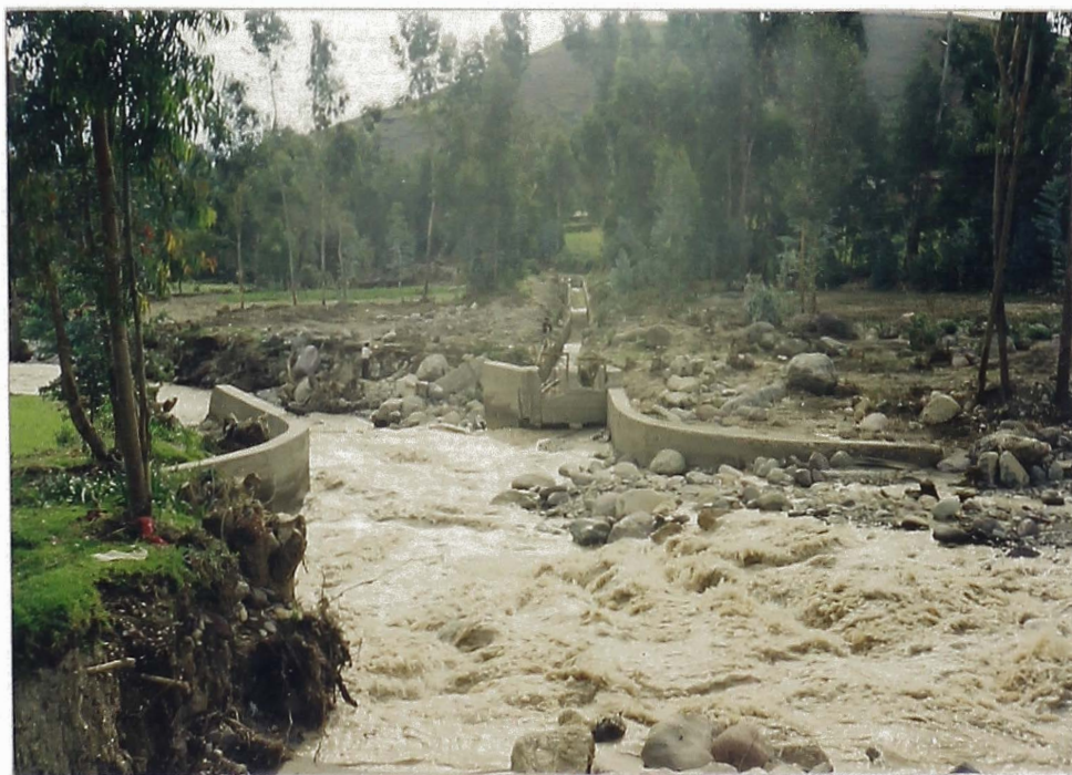
FOTO N o 14.- Vista de la bócatoma destruida, por la fuerza de arrastre del aluvión, hoy se está reparando y limpiando para que quede operativa. (Ene-93)
