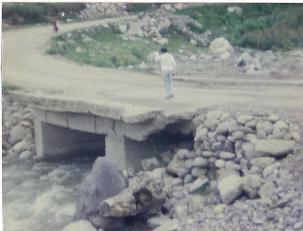
FOTO Nº 06.- Vista del puente del Anexo de Vilcacoto, actualmente se encuentra rehabilitado para el paso de vehículos, pero en lo futuro se tendrá que construir un puente que esta diseñado para resistir un aluvión y otros desastres naturales de mayor grado o similar, así como también una mejor ubicación. (Ene 93)
