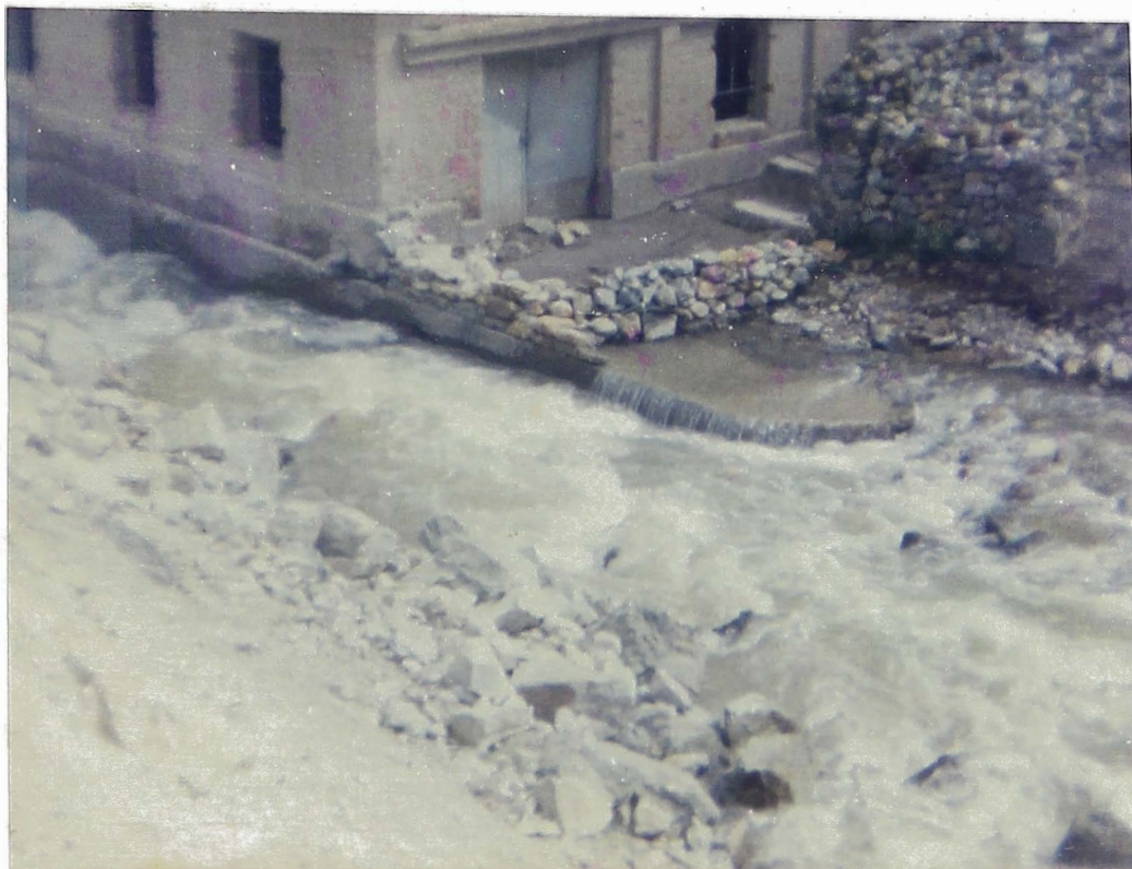
FOTO Nº 05.- Vista de la casa de máquinas de la minicentral hidroeléctrica de Chamicería; aquí no se tuvo idea de un futuro desastre por eso su mala ubicación, nótese que la parte de la infraestructura soportó el aluvión por tener una base sólida de concreto y una construcción en albañilería. eficiente. (Ene 93)
