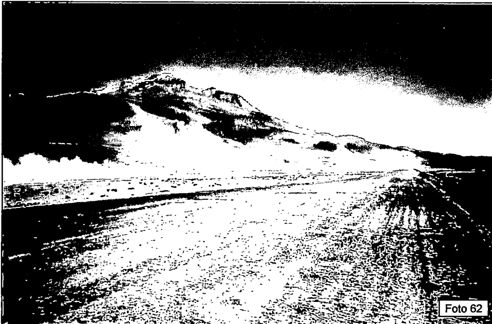
Vistas panorámicas del inicio y final del tramo (km 46+000 – km 53+300), nótese la formación de baches y agregados sueltos por falta de cohesión de los agregados.
