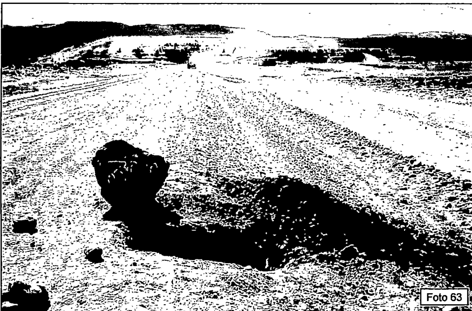
Vistas panorámicas del inicio y final del tramo (km 46+000 – km 53+300), nótese la formación de baches y agregados sueltos por falta de cohesión de los agregados.
