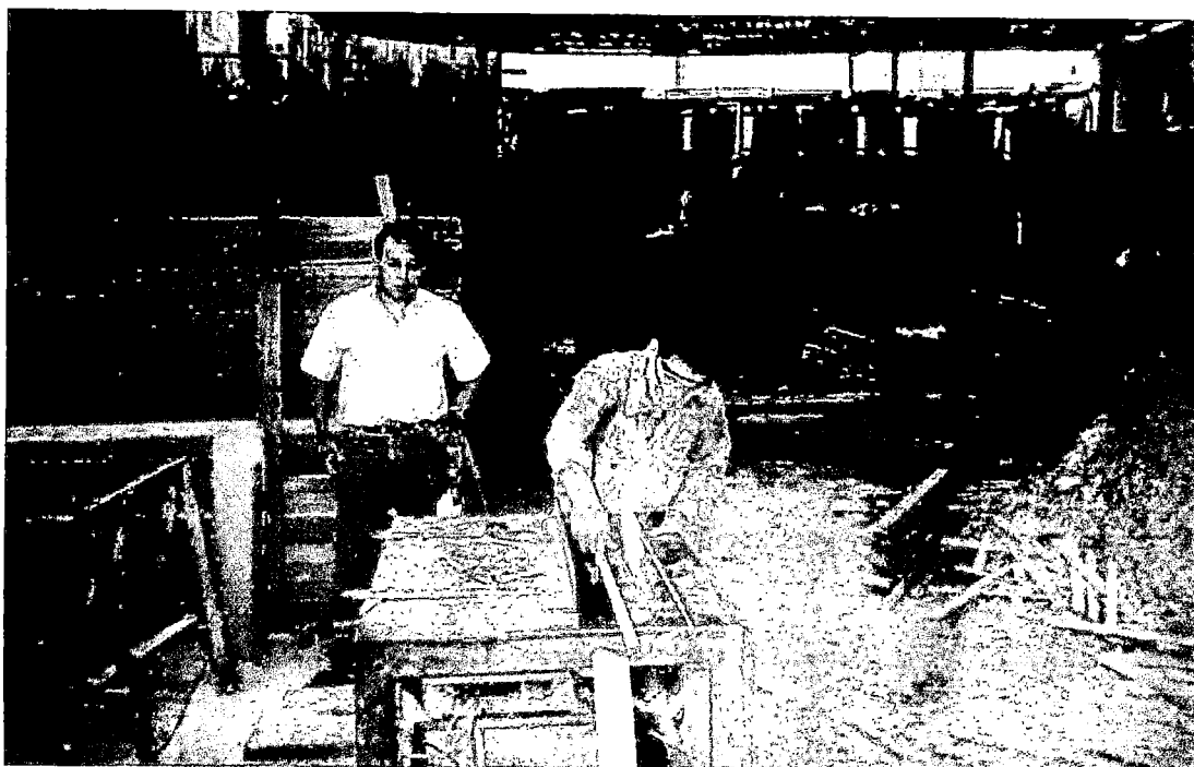
FIG. 4.2 PREPARACION DE LAS VIGUETAS EN UNA MAQUINA CIRCULAR MADERERA MONTOYA S.R.L.
