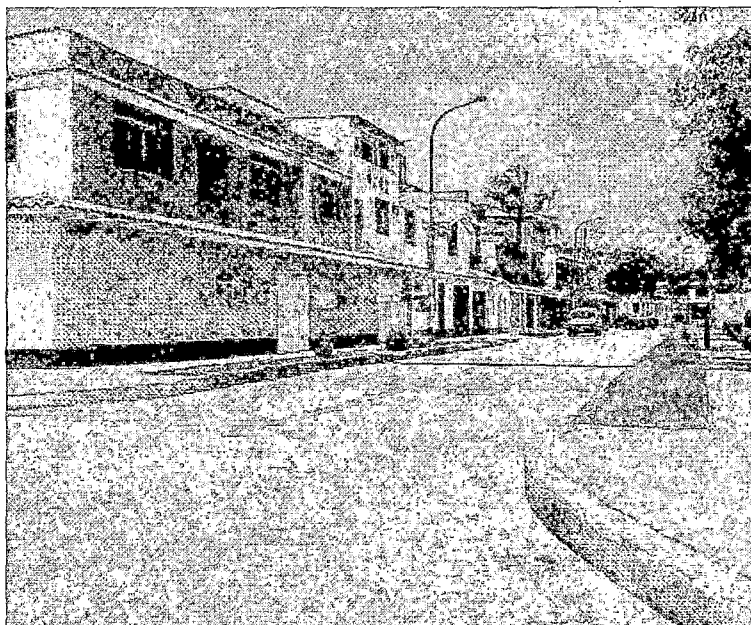
Foto F4-43. Marzo 2003, urbanización Villa Jardín, calle La Malagueña, se apreciaba que las viviendas son de 2 a 3 pisos, existiendo una adecuada conjunción con las áreas verdes.
