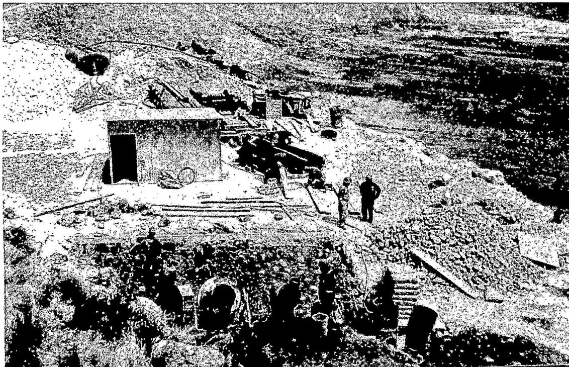
FOTO A 5.6: SE MUESTRA LA CONSTRUCCIÓN DE LA LOSA DE CONCRETO PARA LA INSTALACIONDE LA MAQUINARIA DE PERFORACIÓN (RAISE BORING).
