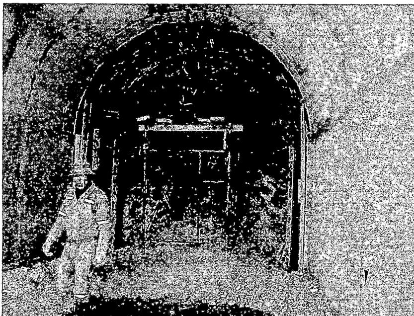
FOTO A 5.35: EN ESTA FOTO SE OBSERVA LA EJECUCIÓN DEL TUNEL DE 100 M, EN ESTE CASO NO SE ESTA UTILIZANDO SOSTENIMIENTO DE SHOCRETE O SPLIT SETS, MALLA ELECTROSOLDADA TODA LA ESTRUCTURA ES DE CONCRETO CON RIELES A CADA 1.80 M.
