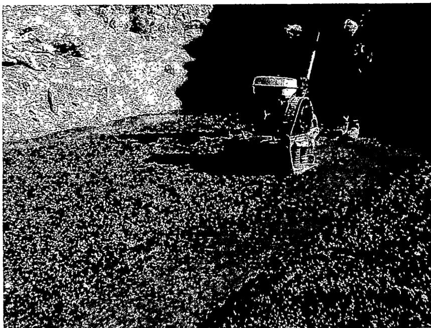
FOTO A 5.32: EN LAS FOTOS SE OBSERVA LA COLOCACIÓN Y EL COMPACTADO DE AFIRMADO DONDE SE CONSTRUIRA EL EDIFICIO WINCHE.
