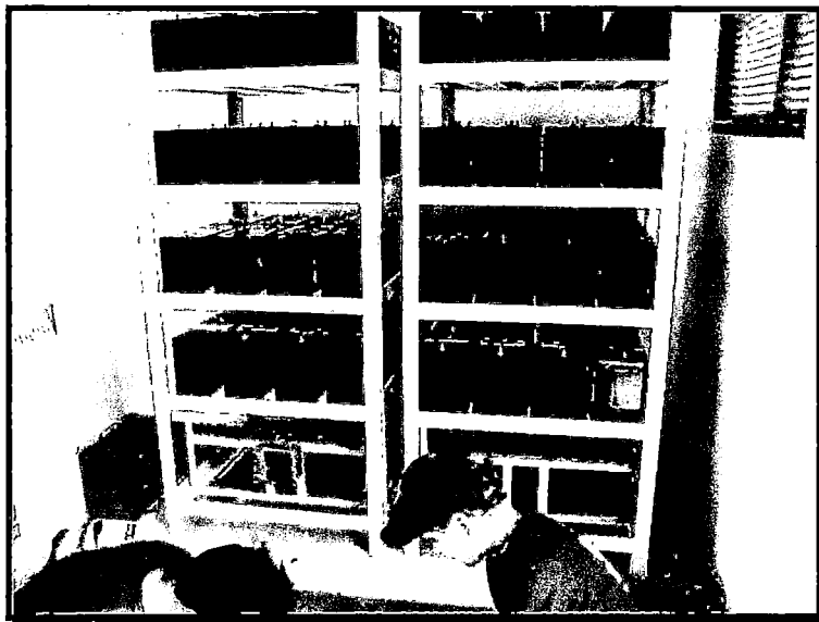
Fotografía 3.91. El sistema Ininterrumpido de Energía o UPS requiere de un banco de baterías que guarden las energía cuando este entre en funcionamiento.
