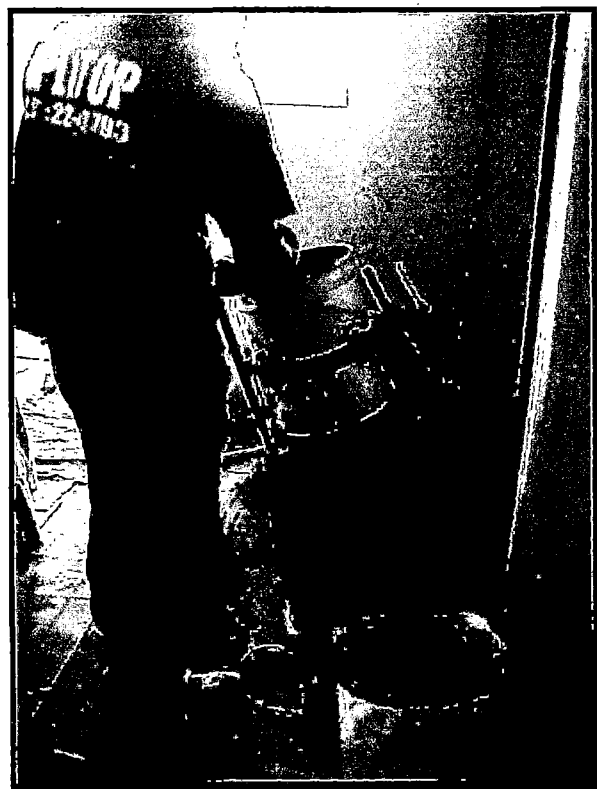
Fotografía 3.4. Preparación del Mortero Epóxico que cubrirá el piso con un espesor de 6 mm.
