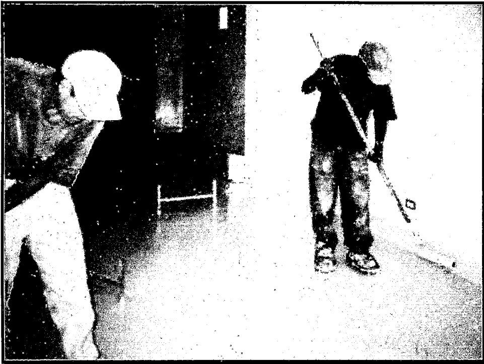
Fotografía 3.21. Para el acabado final, "piel de naranja" se utiliza con rodillo, este acabado permitirá en la superficie la rugosidad necesaria para el trabajo médico en estos ambientes.
