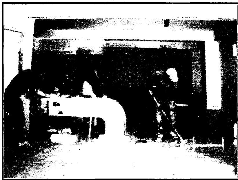
Fotografía 3.19. Luego con ayuda de escobillas de jebe se esparce el producto uniformemente en el ambiente a aplicarse.
