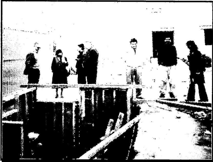
Fotografía 3.77. El Tanque de Petróleo está ubicado en la zona de servicio, este estará encargado de suministrar el petróleo al Grupo Electrónico, Caldero de Vapor e Incinerador.
