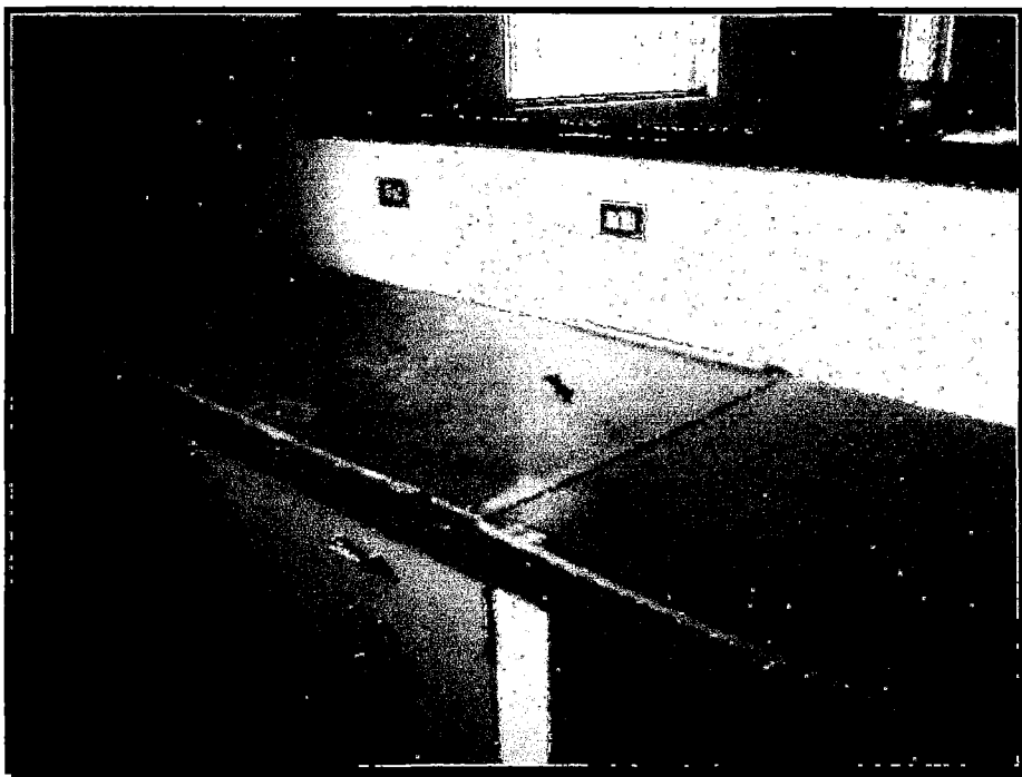
Fotografía 3.24. En la primera etapa se moldea según las medidas de las mesas y procede a realizar el corte de las planchas acrílicas.
