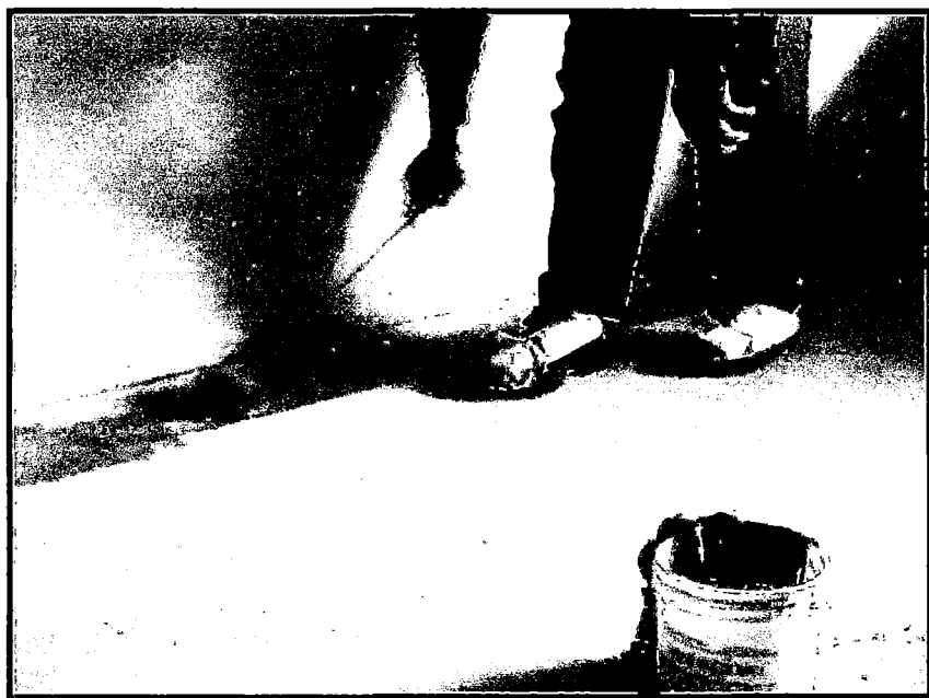
Fotografía 3.3. Posteriormente se procede con ayuda de un rodillo a imprimir el piso, que recibirá al mortero epóxico, primera se empieza por las juntas sanitarias.
