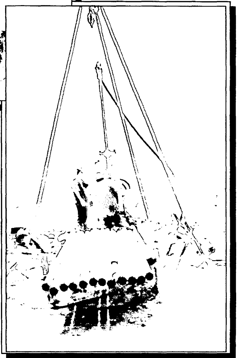
Foto N° 06: Vista de la perforación diamantina P-03 en la corona de la presa principal Tinajones
