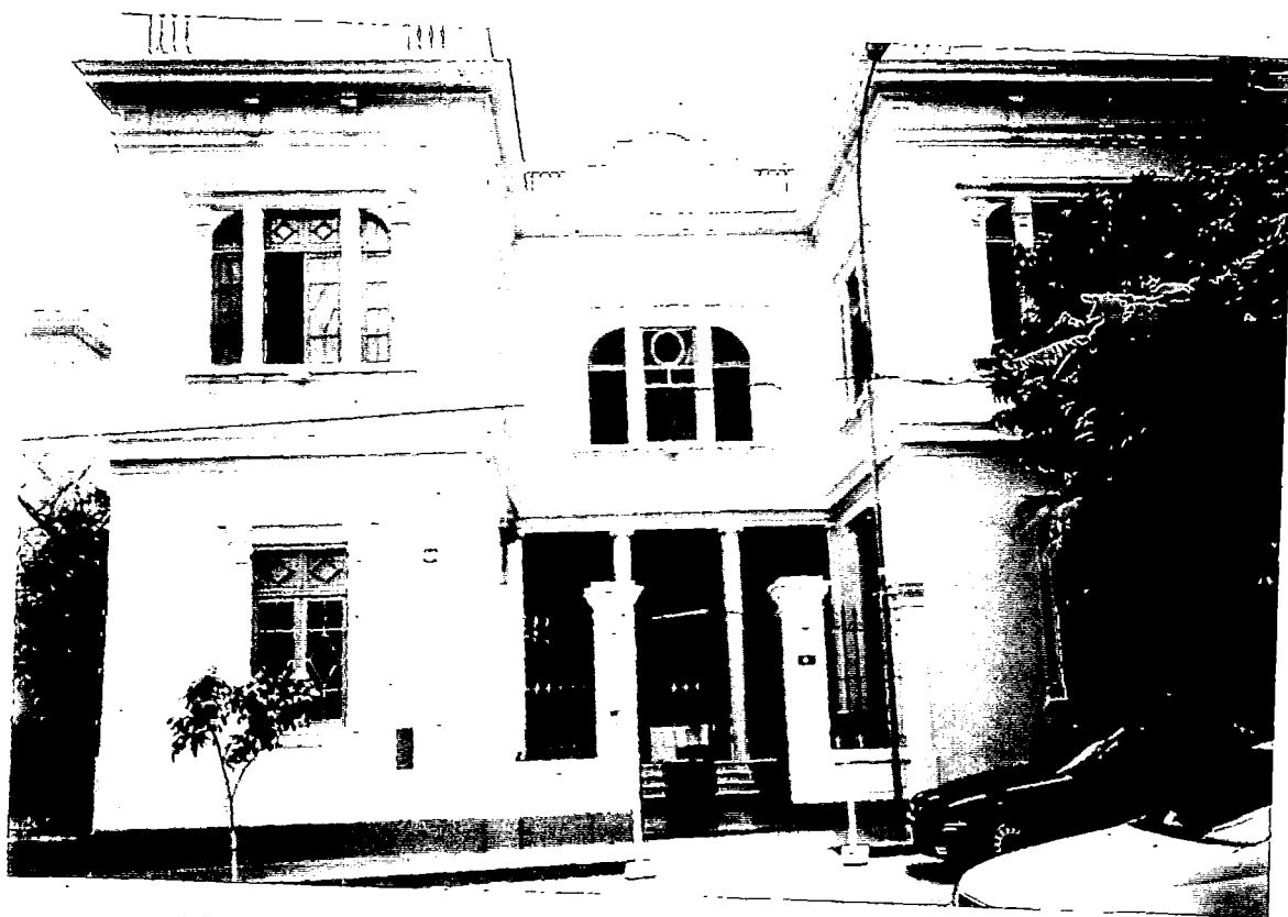
FOTO 63 : GALERÍA DE ARTE "LUCÍA DE LA PUENTE" (casona restaurada el año 2002 e inaugurada como galería en febrero del 2003)
