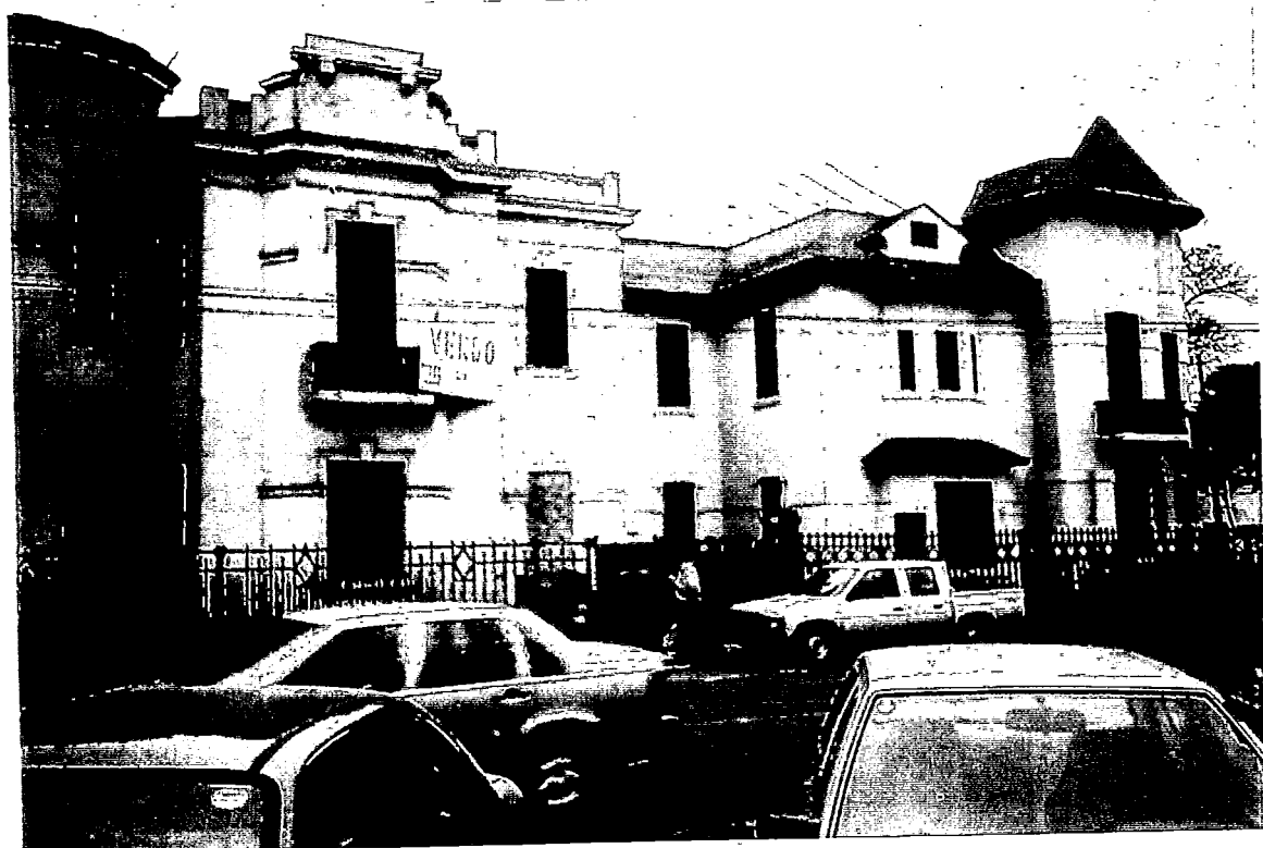
FOTO 43 : CASONAS EN VENTA OLVIDADA Y DESCUIDADA (ubicada en la Av. Grau)
