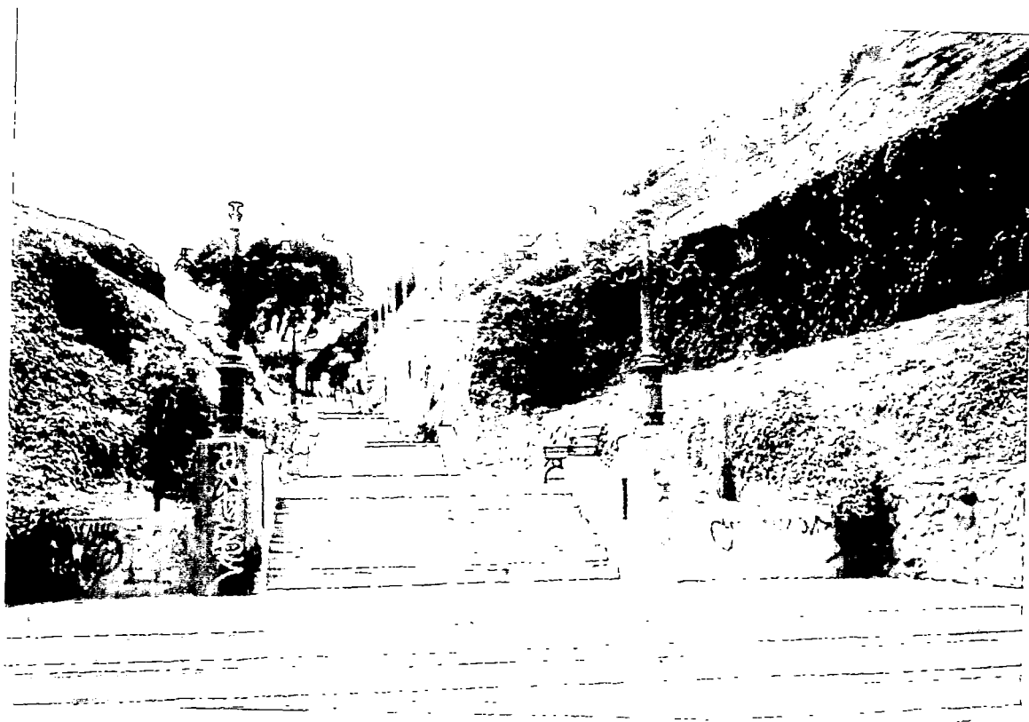
FOTO 54 : VISTA DE LA BAJADA A LOS BAÑOS DESDE EL ACANTILADO
