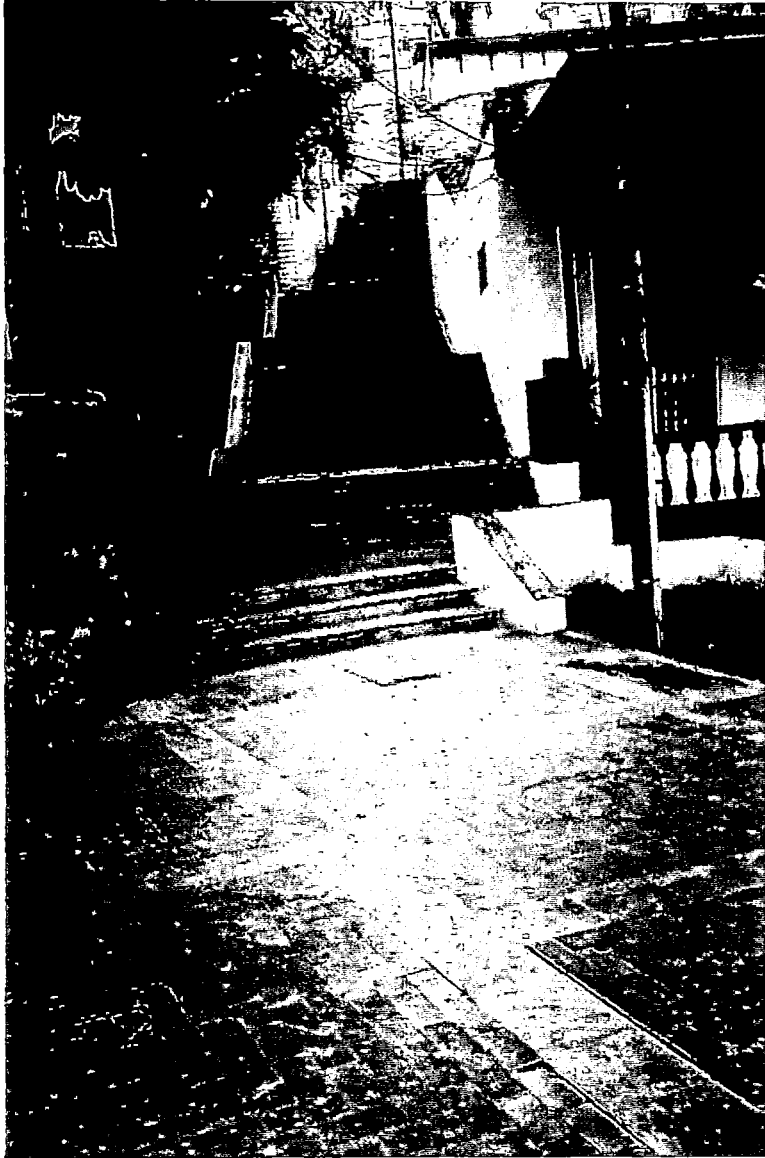
FOTO 25 : BAJADA LA OROYA
