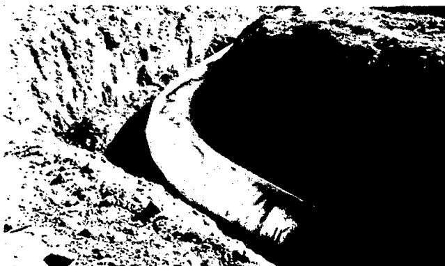
Emballado de 2050mm con entorno de concreto pobre
