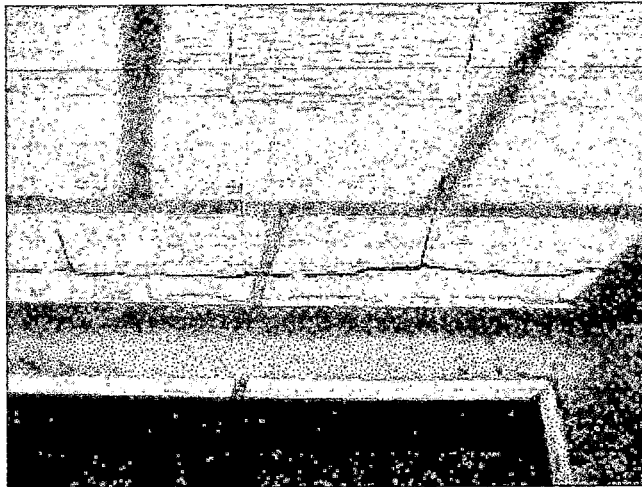
48. Fisuras en la losa de techo
