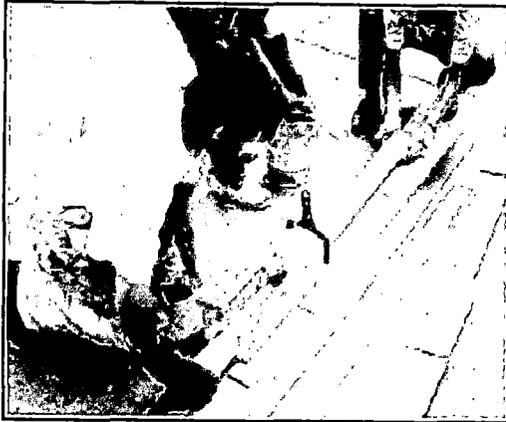
Fig.4.7 Aplicación del adhesivo epoxico sobre la platina de fibra de carbono.
