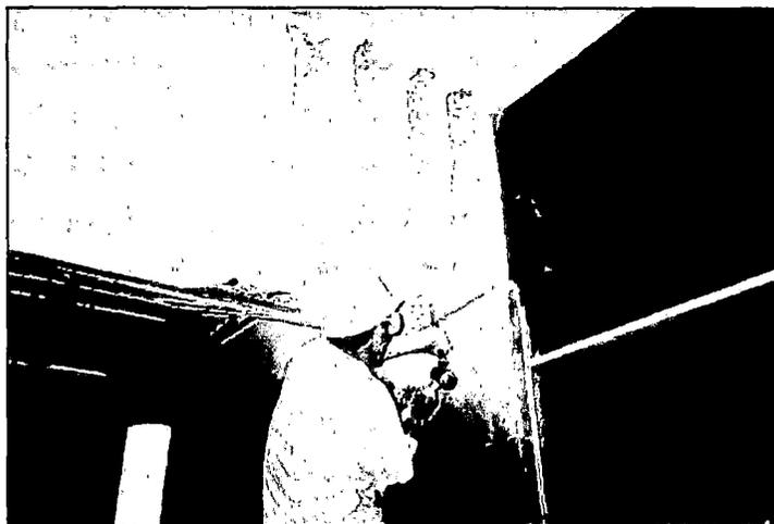
Fig. N° 9.13 Picada del recubrimiento en las caras laterales y cara inferior de la viga.
