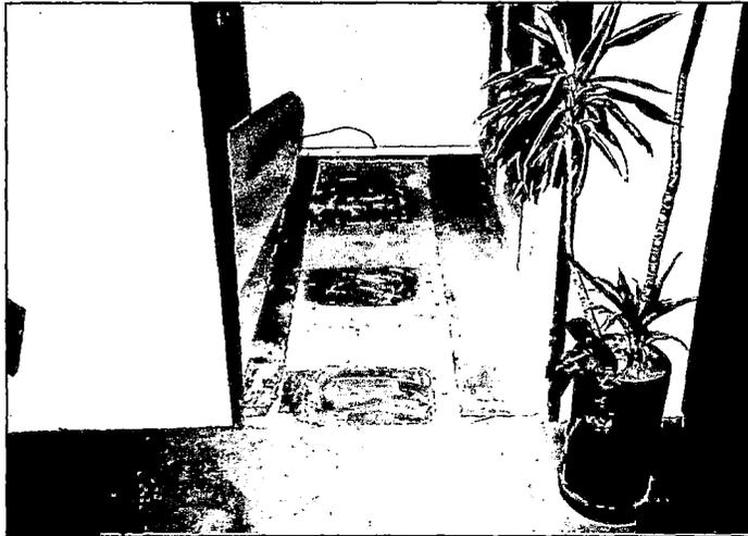
Fig. 9.9 Curado de concreto con membrana Antisol Normalizado,
