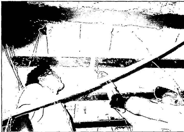
Fig. Nº 9.17 Pasada de rodillo de caucho después de la pega de la fibra de carbono sobre la vigueta.
