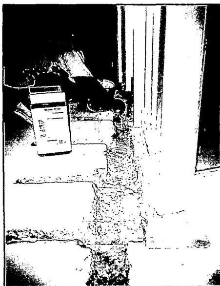
Fig. 3.3 Se observa, la aplicación de pegamento epóxico, sobre una superficie, previamente preparado.
