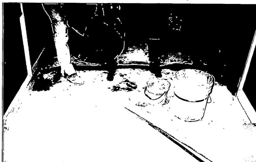
Foto N° 1.4 Vaciado del mortero Sika Grout 212 en las canaletas.
