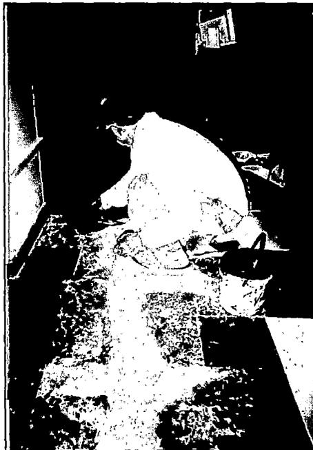
Fig. 9.18 Colocación del piso vinílico, después de haber secado bien el mortero epóxico.
