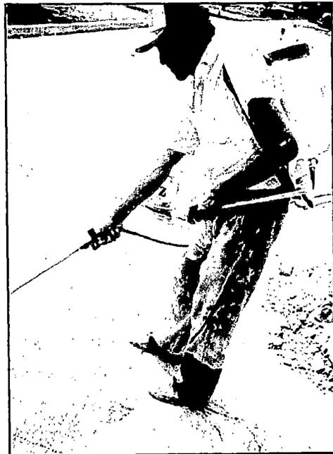
b) Membrana para curado aplicando con un pulverizador.
