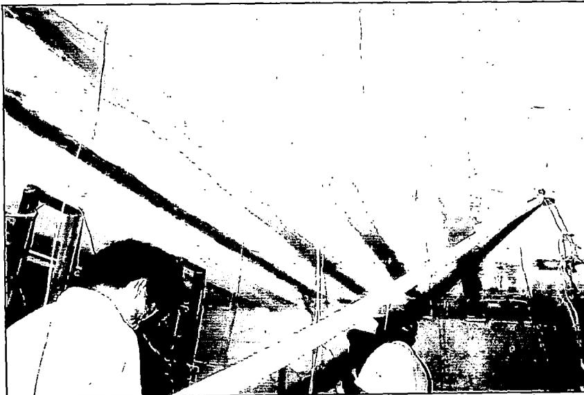
Foto N° 5.2 Aplicación del adhesivo epóxico Euco 452 Gel sobre la superficie de concreto.
