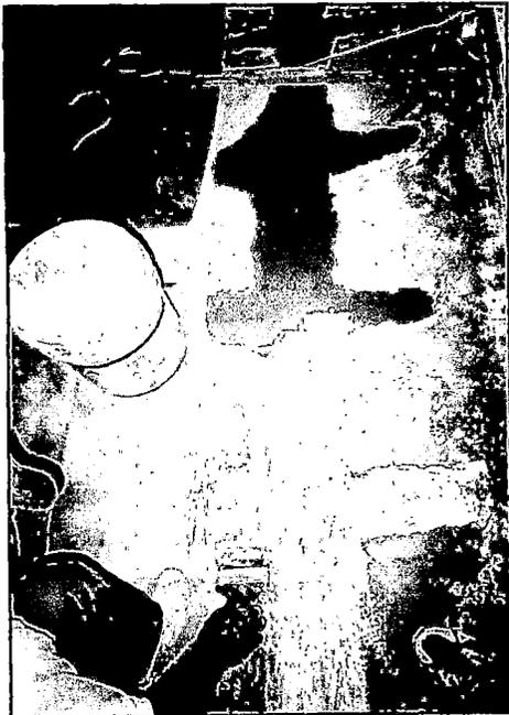
a) Membrana para curado aplicando con una brocha sobre mortero
