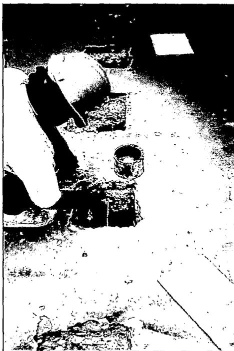
Fig. 9.8 Aplicación del pegamento epóxico en las cajuelas
