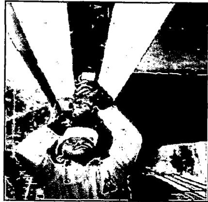
Fig.4.8 Pasada de rodillo sobre la platina inmediatamente después de la pega.
