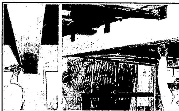
Vista fotográfica de reforzamiento de una viga de concreto armado mediante platinas de fibra de carbono
