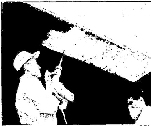
Fig.4.3 Preparación de la superficie de concreto.
