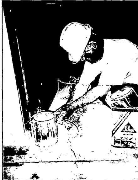
Fig. 9.2 Aplicación del pegamento epóxico en toda superficie de la canaleta en la losa aligerada.
