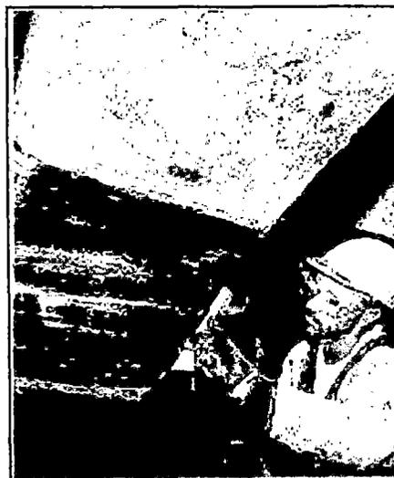
b) Reforzamiento a cortante de viga de concreto armado mediante tejido de fibra de carbono.
