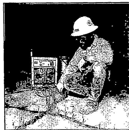
Fig. 3.7 Inyección de grietas
