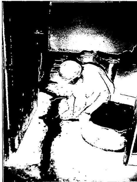
Fig. 9.4 Colocación del mortero epóxico a lo largo de la canaleta y de los cortes transversales
