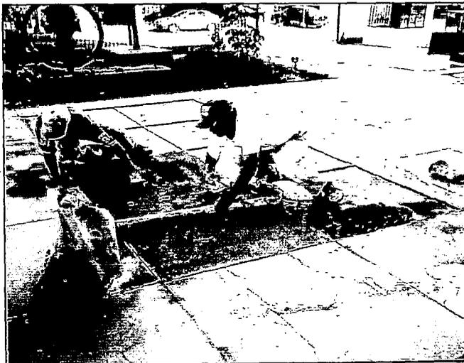
Foto N° 6.3 Colocación del piso terrazo lavado
