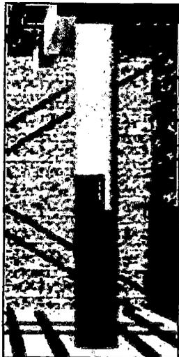
a) Reforzamiento de columna de sección circular
