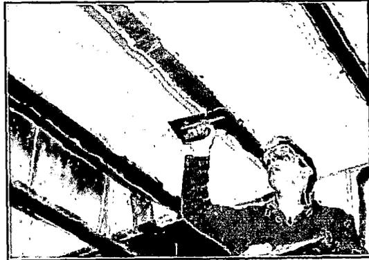
Fig.4.6 Aplicación del adhesivo epóxico sobre la superficie de concreto.
