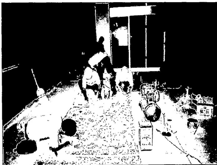
Fig. 9.10 Aplicación del pegamento epóxico sobre la superficie de concreto antiguo.
