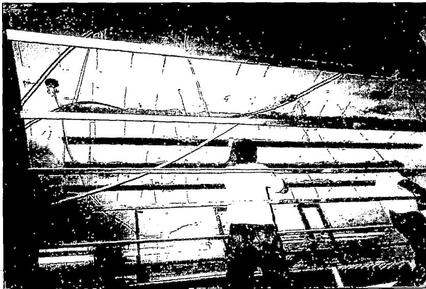
Foto N° 5.4 Las láminas de fibra de carbono son colocados
