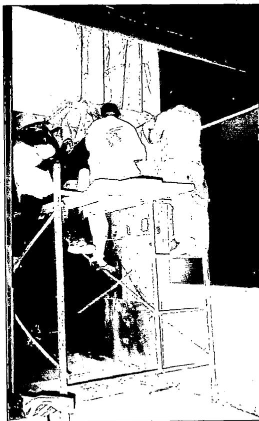
Foto N° 4.4 Encofrado de viga para el vaciado del mortero predosificado
