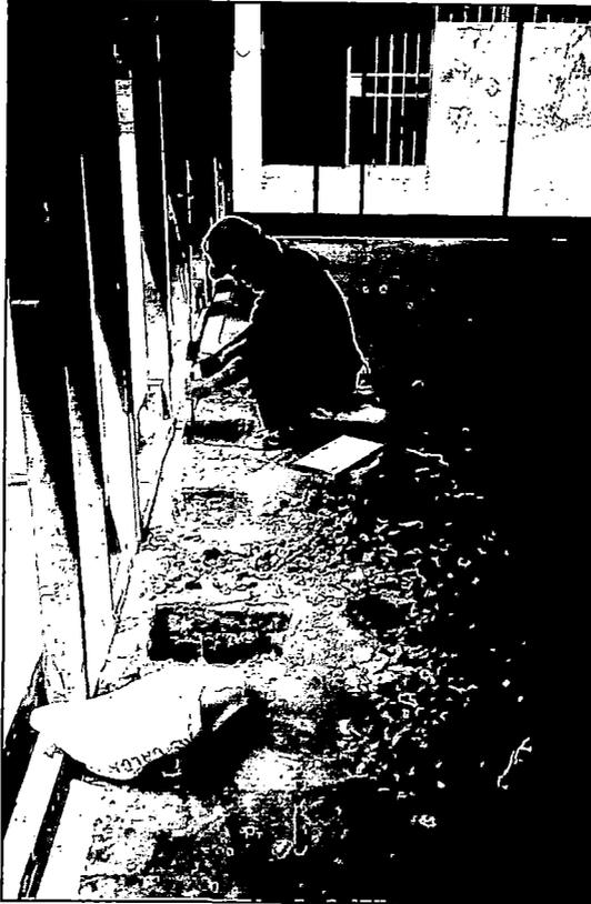
Foto N° 2.1 Conformación de cajuelas en losa aligerada
