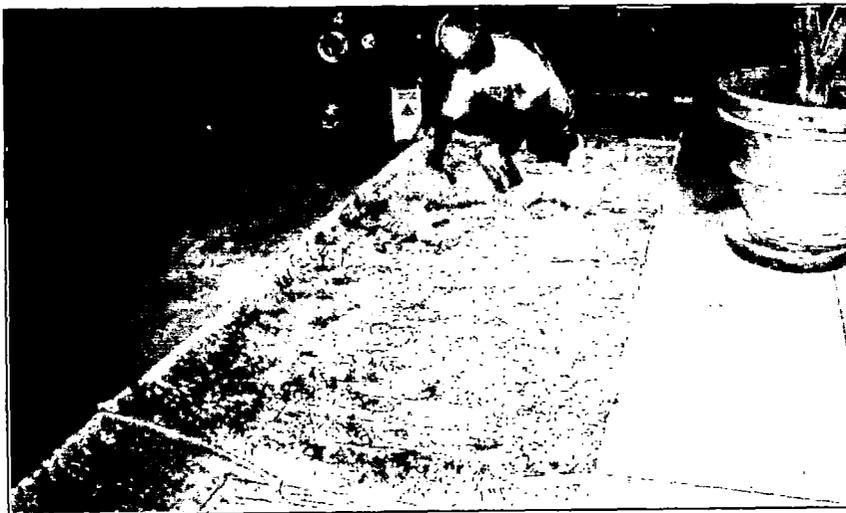
Foto N° 3.2 Pintado con pegamento epóxico Sikadur 32 Gel sobre la superficie de concreto existente.
