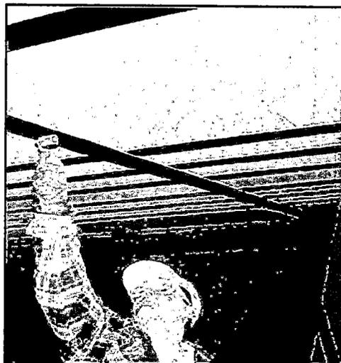
b) Colocación de fibra de carbono.
