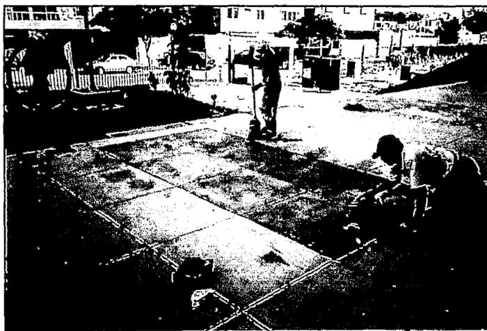
Fig. 9.20 Colocación del piso terrazo lavado.
