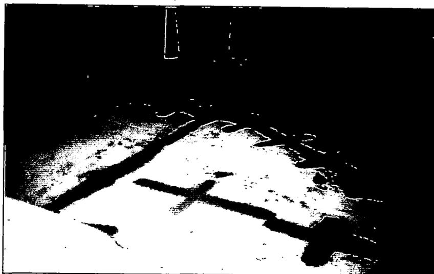
Foto N° 1.5 Vista de reparación de grietas con mortero Sika Grout 212
