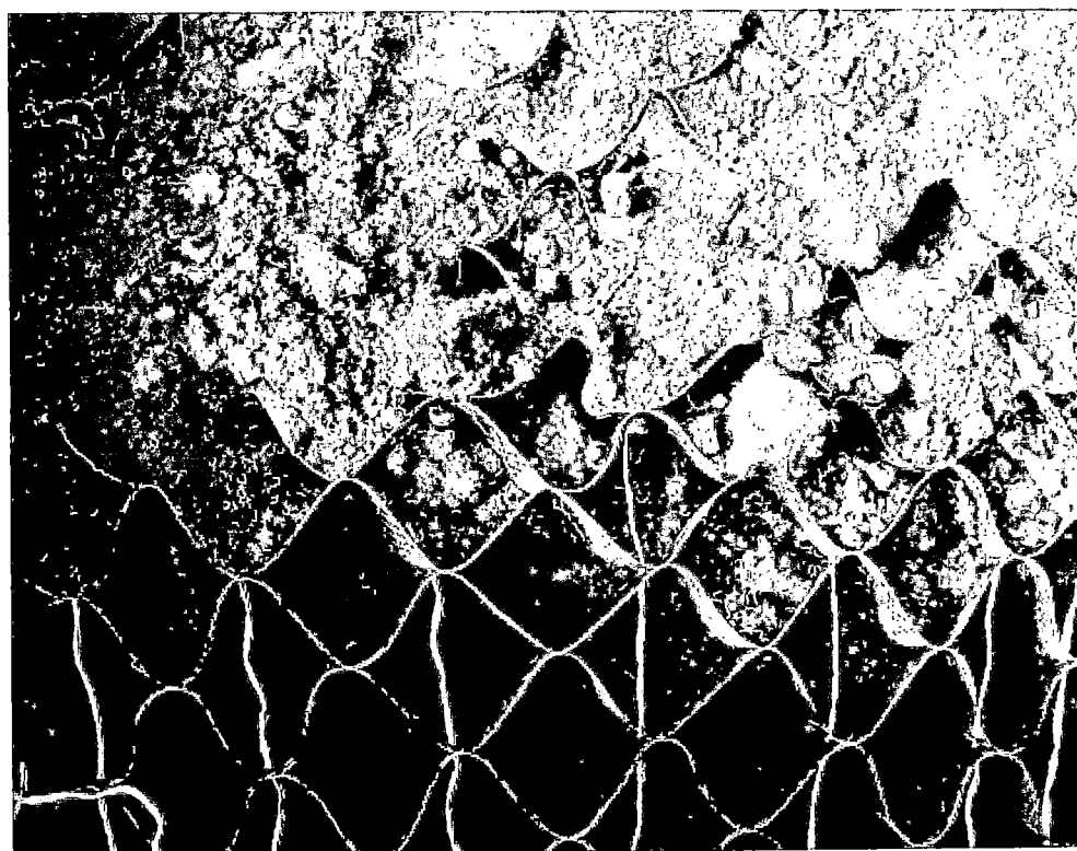
FOTO E-30. Instalación de Geoweb®: Durante la colocación de tierra en las geoceldas.
