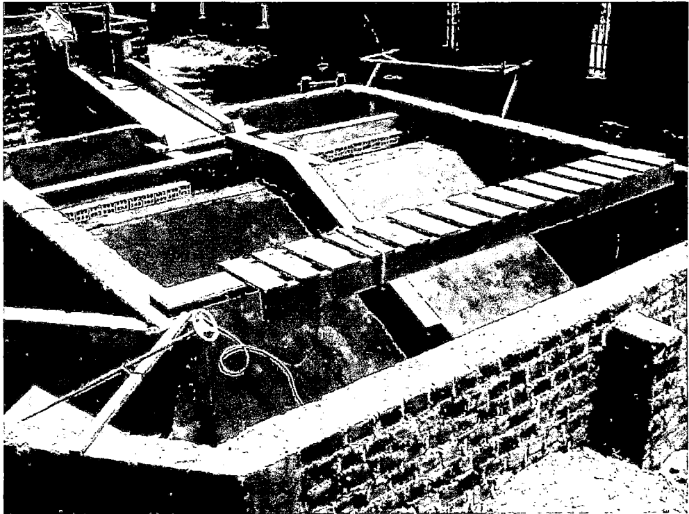
FOTO E-3. Vista de los taludes nivelados con tierra orgánica. En un principio se pensó que era mejor regar el talud con geotextil, esta idea no tuvo éxito.
