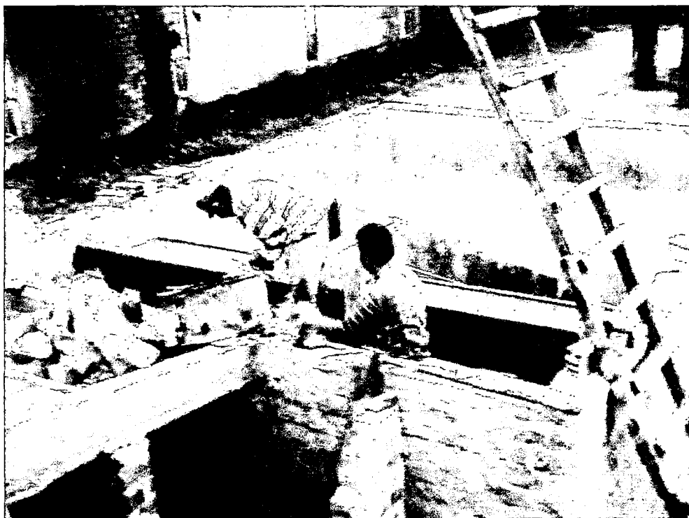
FOTO E-1. Fase de construcción: Construcción de la poza disipadora.
