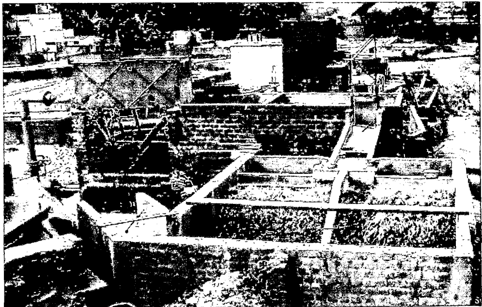
FOTO E-34. Vista de la estructura luego de 60 días desde la siembra. Se observa el mayor crecimiento en el talud de la derecha, el cual está con Geoweb®, a pesar que es unos días más joven.
