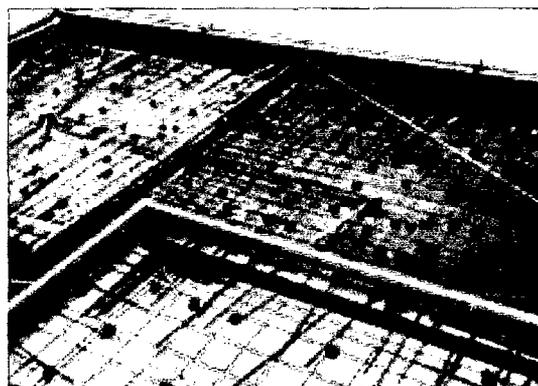
**Foto 2.8 – Montaje del refuerzo de la losa**
