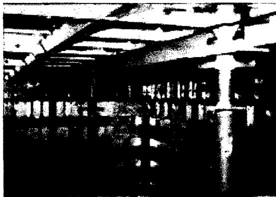
**Foto 2.6 – Montaje de formaletas de losa**
