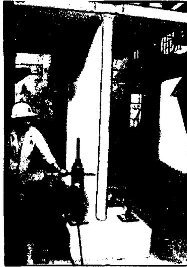
**Foto 4.7 - Ajuste de pernos para fijar la viga de cimentación a la losa de ensayo**
