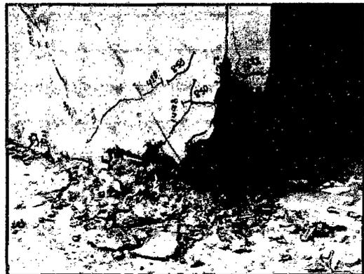
**Foto 5.18** – Detalle de trituración en el talón derecho.
