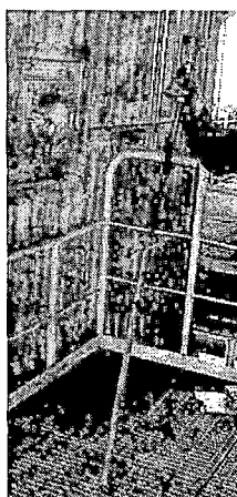
Figura 6.9. Termocupla para temperatura de gases a la salida del hogar
