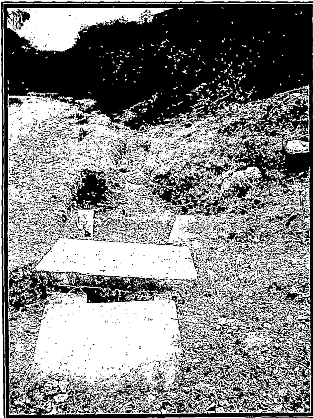
Fotografía Nº 4.41 Centro poblado de San Juan de Obrajillo. Pequeño canal mixto (revestido por tramos) usado para la irrigación de las tierras cercanas al río Chillón.
