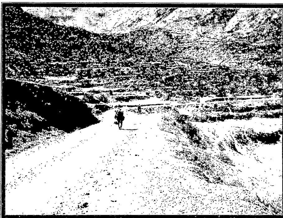
Fotografía Nº 4.12 Distrito de Canta. Carretera Canta – La Viuda
