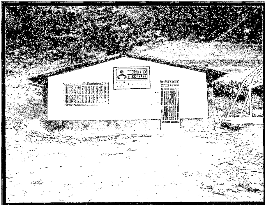
Fotografía Nº 4.25 Centro poblado de Paríamarca. Vista frontal del Puesto de Salud de Paríamarca
