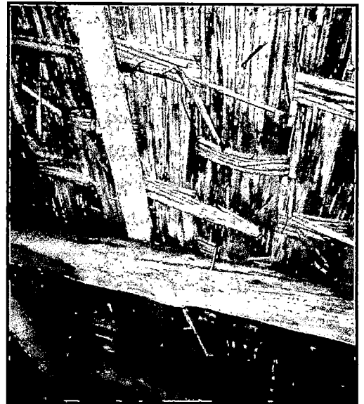
FOTO N° 5.25: En la foto se aprecia la paja entretejida colocada para el sostenimiento de las tejas.
