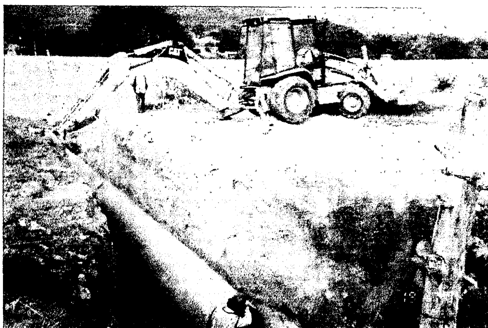
Colocación del tubo: ALC 0+920
