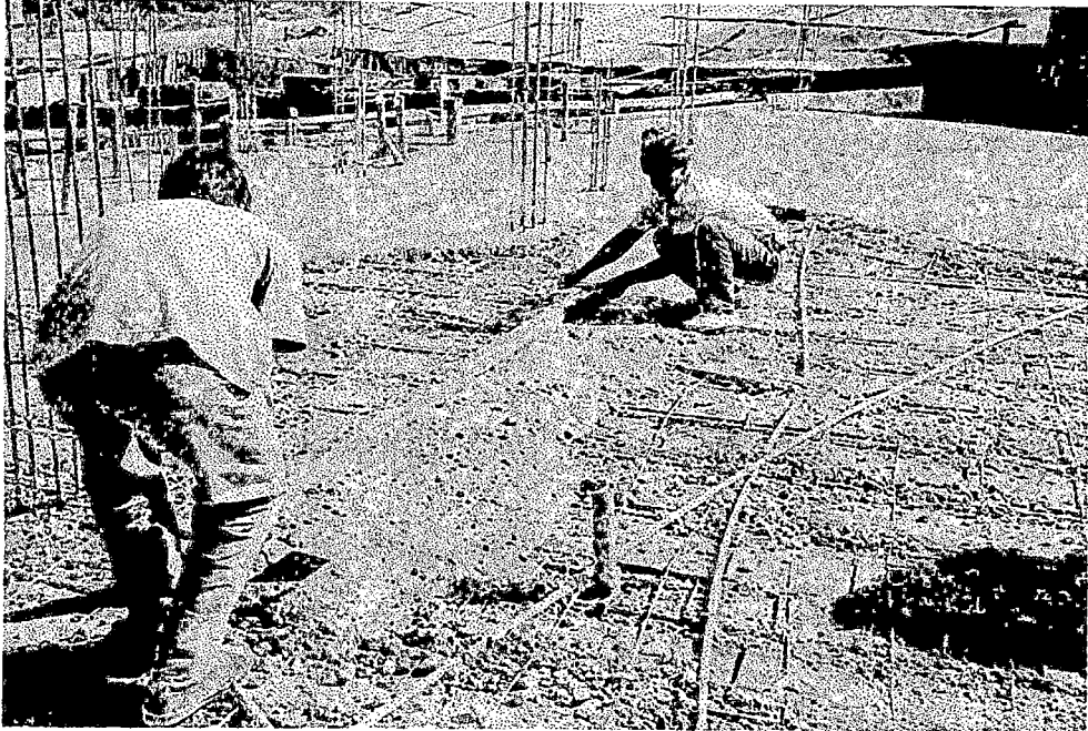
Nivelación de la losa del techo aligerado
