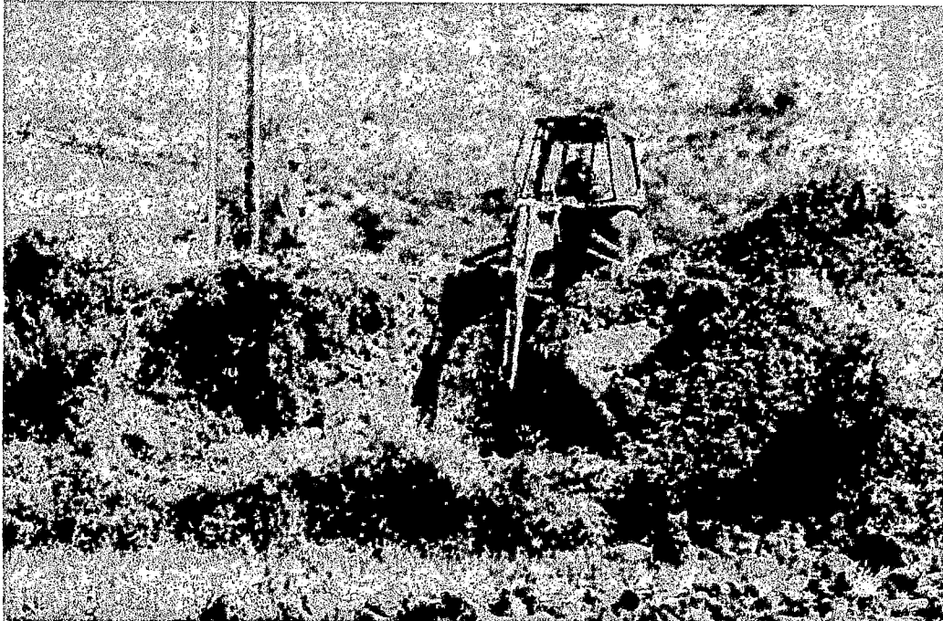
Excavación de ALC Km. 15+711
