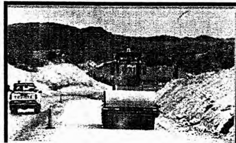
INICIO DE LA COMPACTACION
