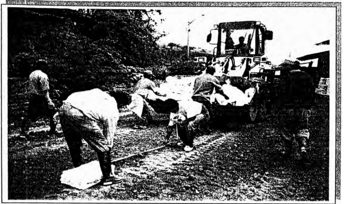
FOTO N° 5 Se aprecia al personal colocando las bolsas de RBI al tramo.
