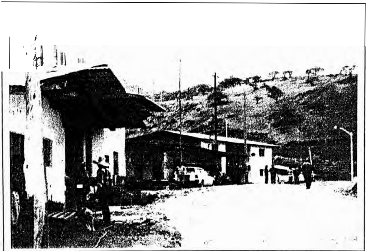
FOTO N° 6 Se aprecia el extendido del RBI Grado 81 en toda la superficie a estabilizar.
