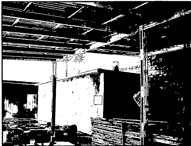
Foto N° 1-03.- Vigas y columnas laminadas de madera de Pinus radiata
