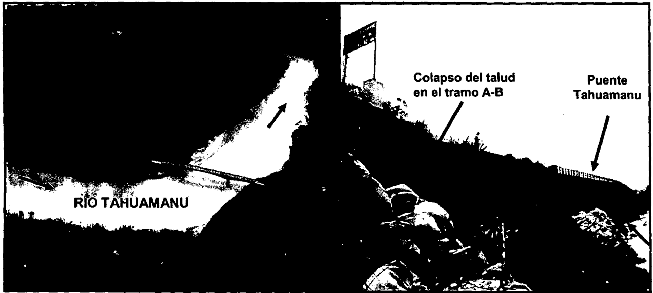
Foto 1.09. Erosión lateral en la zona del puente Tahuamanu.
