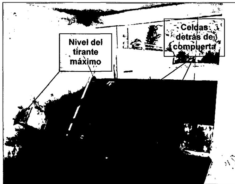
Figura 4.2-15 - Vista aguas arriba de una compuerta radial parcialmente abierta
