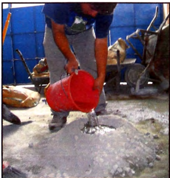
Figura 8.- Se agrega el agua que requiere a la mezcla y se deja reposar unos minutos Fuente: (Elaboración propia)
