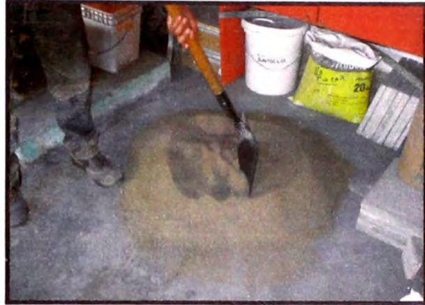
Figura 10.- Cuarteo del agregado fino con la lampa para homogenizar la mezcla. (Fuente: Elaboración propia)
