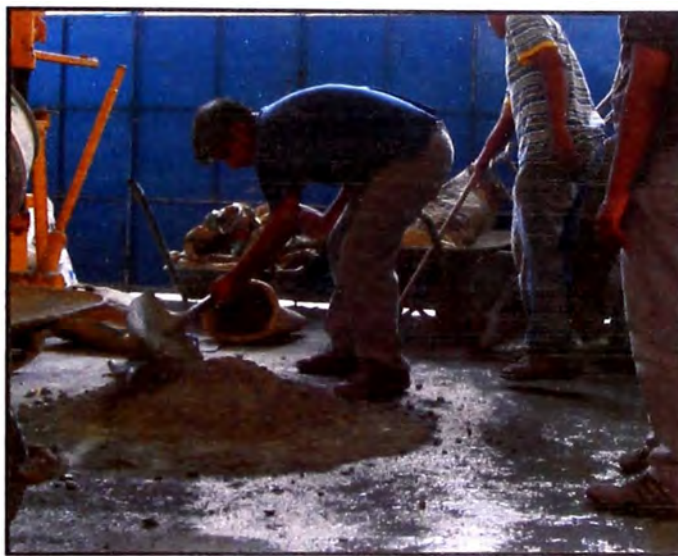
Figura 7.- Se procede a uniformizar la mezcla de piedra, arena gruesa y cemento. Fuente: (Elaboración propia)
