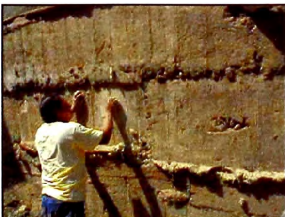
Figura 15. – Preparando la superficie a ser ensayada en la cimentación de la vivienda. (Fuente: Elaboración propia)
