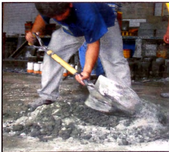
Figura 9.- Se procede a realizar movimientos con la lampa hasta tener una mezcla uniforme. Fuente: (Elaboración propia)
