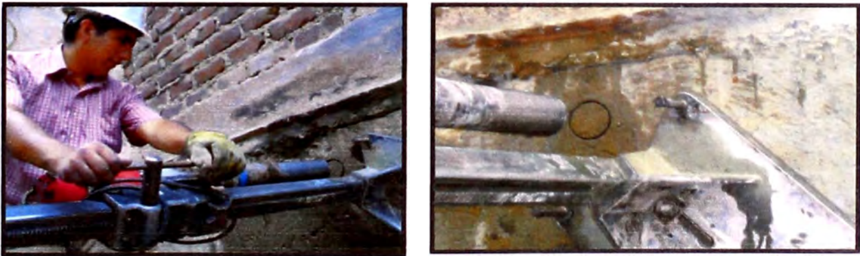
Figura 5.- Se puede notar la manera como se está extrayendo la muestra de testigo cilíndrico.
