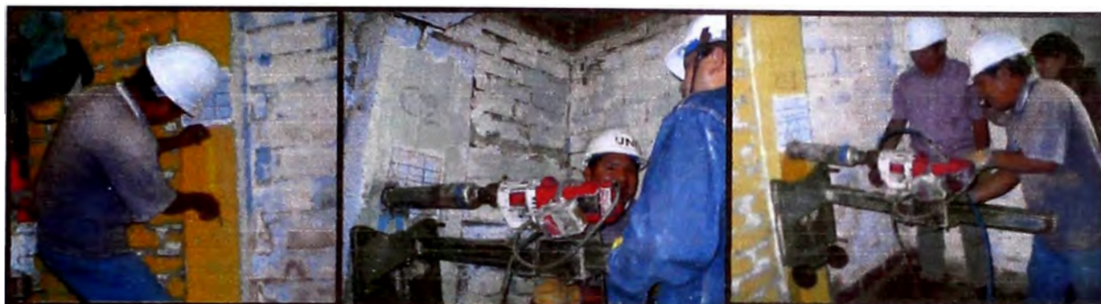
Figura 7.- Se ubica el área donde se va extraer la muestra, se instala el equipo para proceder a extraer la muestra. Fuente: (Elaboración propia)
