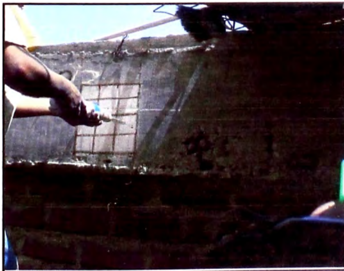
Figura 29. – Aquí se puede notar que se está haciendo los disparos a la viga y obtener los resultados de rebote. (Fuente: Elaboración propia)
