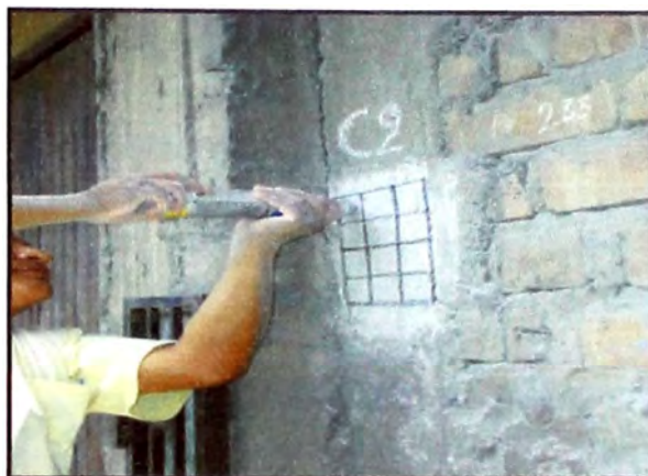
Figura 18. — Haciendo el ensayo de en la columna C2 (Fuente: Elaboración propia)
