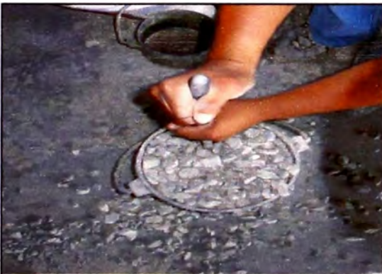
Figura 15. -Al compactar se reduce el área de vacíos. (Fuente: Elaboración propia)
