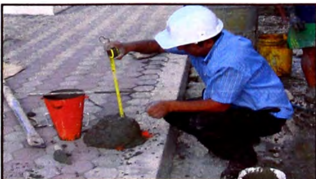
Figura 13.- Se hace la lectura de cuanto es el asentamiento. Fuente: (Elaboración propia)
