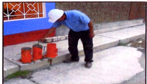
Figura 14.- Se llenan las 3 probetas con concreto para ser ensayadas en laboratorio
