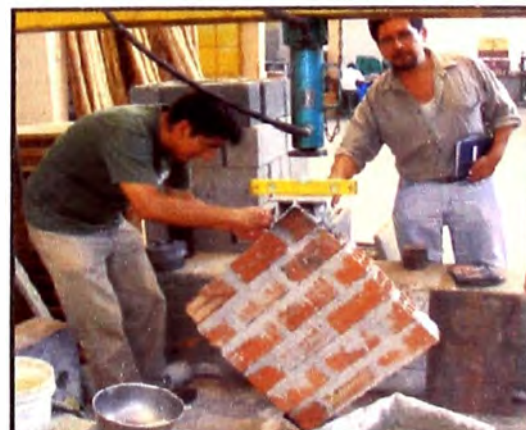
Figura 19. – Murete siendo nivelado y aplomado. (Fuente: Elaboración propia)
