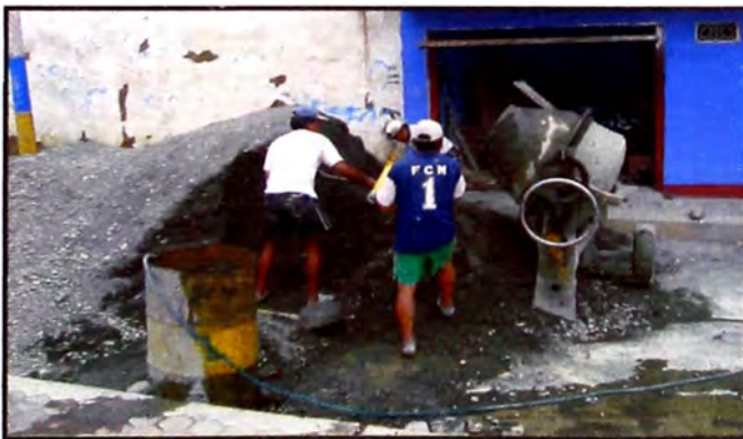
Figura 12.- Se puede ver como se mezcla el concreto en el trompito que se está utilizando en el techado, se extrae una porción de concreto para hacer la medición del asentamiento del concreto con el Cono de Abrams. Fuente: (Elaboración propia)
