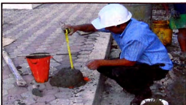
Figura 13.- Se hace la lectura de cuanto es el asentamiento.
