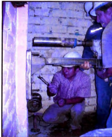
Figura 1.- Extracción de testigos diamantinos (Fuente: Elaboración propia)
