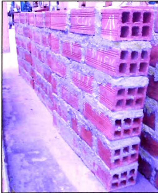
Figura 2.- Murete de ladrillo pandereta (Fuente: Elaboración propia)
