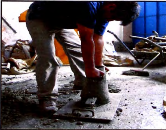
Figura 10.- Se hace la medición de asentamiento de concreto con la prueba del Cono de Abrams. (slump). Fuente: (Elaboración propia)
