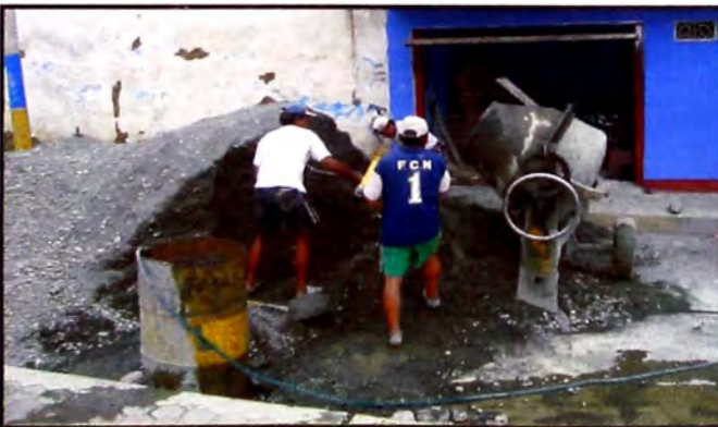
Figura 12.- Se puede ver como se mezcla el concreto en el trompito que se está utilizando en el techado, se extrae una porción de concreto para hacer la medición del asentamiento del concreto con el Cono de Abrams.
