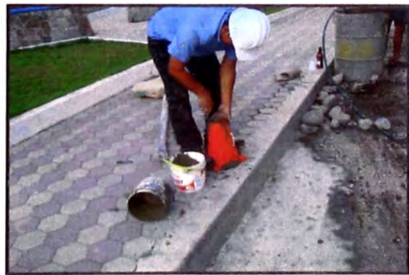
Figura 12.- Se puede ver como se mezcla el concreto en el trompito que se está utilizando en el techado, se extrae una porción de concreto para hacer la medición del asentamiento del concreto con el Cono de Abrams. Fuente: (Elaboración propia)
