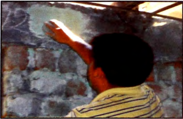
Figura 27. – Preparación de la superficie de la viga a ser ensayada. (Fuente: Elaboración propia)
