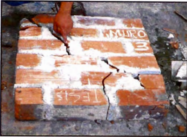
Figura 24. – Aquí se puede notar la falla por tracción diagonal.
