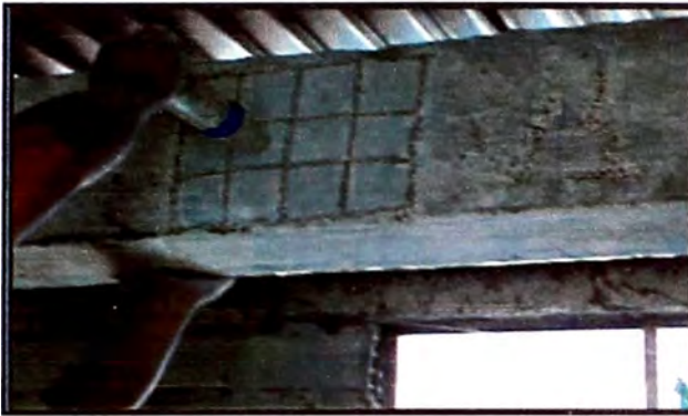
Figura 11. – Haciendo los disparos con el esclerómetro en la viga V1. (Fuente: Elaboración propia)
