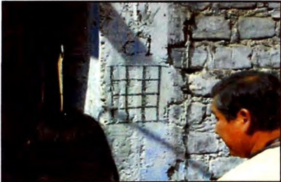
Figura 23. – Columnas C1 lista para ser ensayada (Fuente: Elaboración propia)
