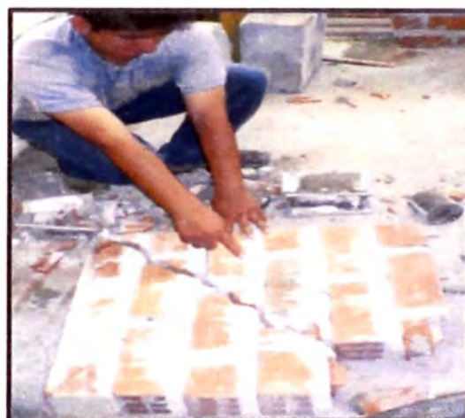
Figura 17. – Aquí se puede ver por donde a fallado por el ladrillo. (Fuente: Elaboración propia)
