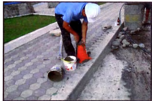
Figura 12.- Se puede ver como se mezcla el concreto en el trompito que se está utilizando en el techado, se extrae una porción de concreto para hacer la medición del asentamiento del concreto con el Cono de Abrams.
