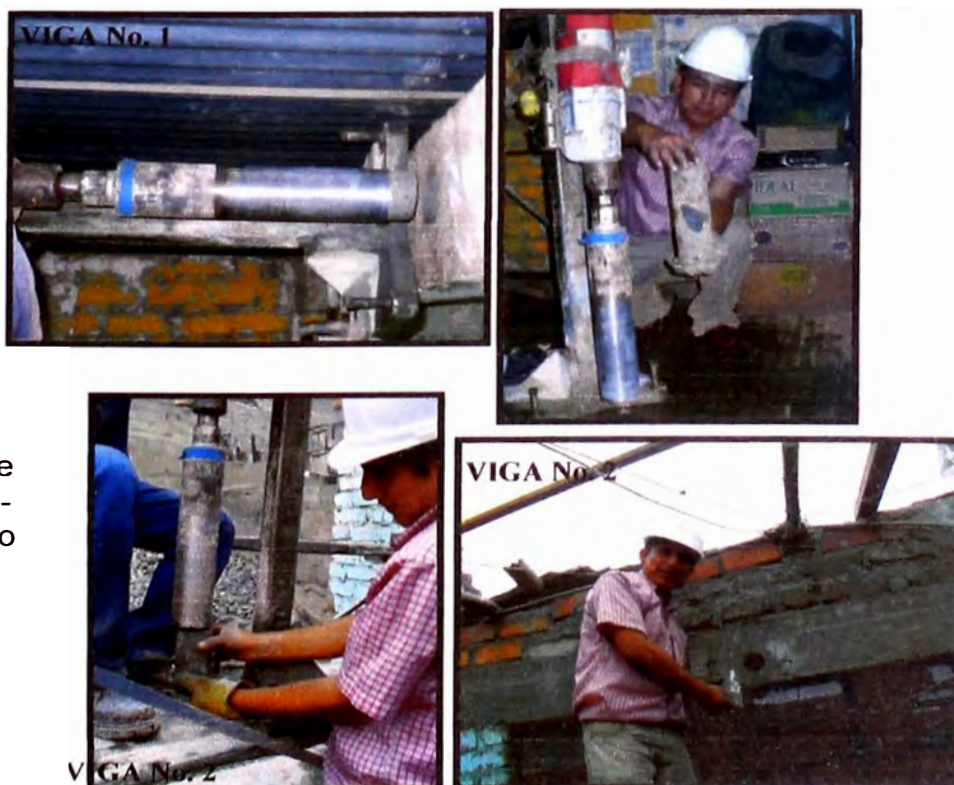
Figura 10.- Se ubica el lugar donde se va extraer la muestra de concreto para lo cual se esta colocando pernos de anclaje y se procede a instalar el equipo. Fuente: (Elaboración propia)
