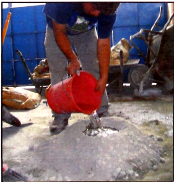
Figura 8.- Se agrega el gua que requiere a la mezcla y se deja reposar unos minutos Fuente: (Elaboración propia)
