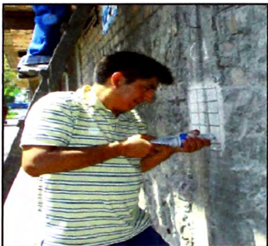
Figura 17. — Haciendo el ensayo de en la columna C1 (Fuente: Elaboración propia)
