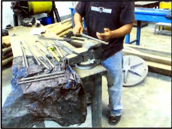
Figura 6.-Varilla de acero de 5/8”: Habilitación de los aceros para ser ensayados. (Fuente: Elaboración propia)
