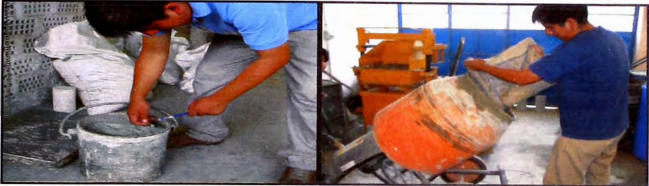
Figura 1.- Se realiza el pesado de cada uno de los componentes del concreto, se procede a llenar los componentes a la mezcladora de concreto.
