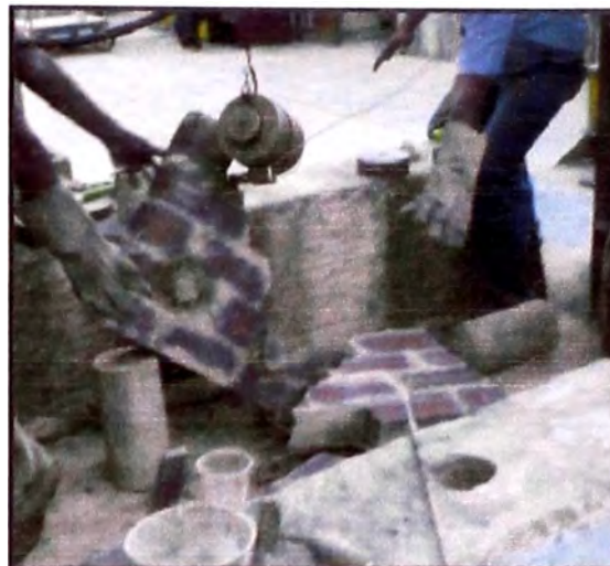
Figura 37. – Instante en que falla el murete 2.
