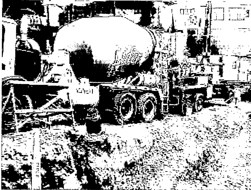
Foto N° 5.03: Concreto Premezclado Para Placas de Muro del Primer Nivel
