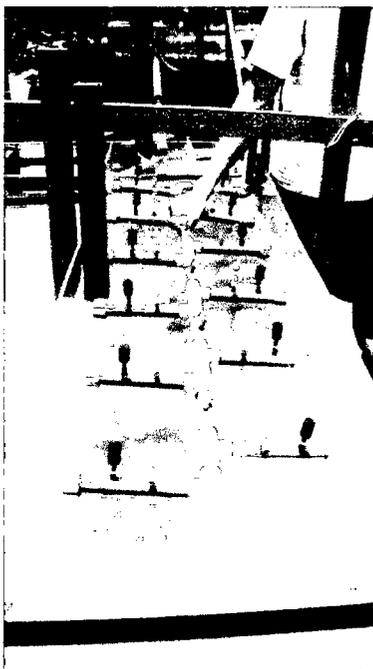
**Fotografía N° 5.16: Red de Tuberías con difusores**
