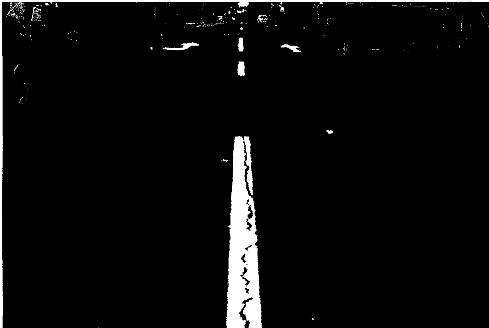
Foto N° 60. Nivel moderado de fisuramiento longitudinal con ramificaciones
