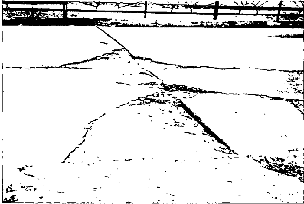
Foto N° 76. Nivel alto de despostillamiento de juntas.
