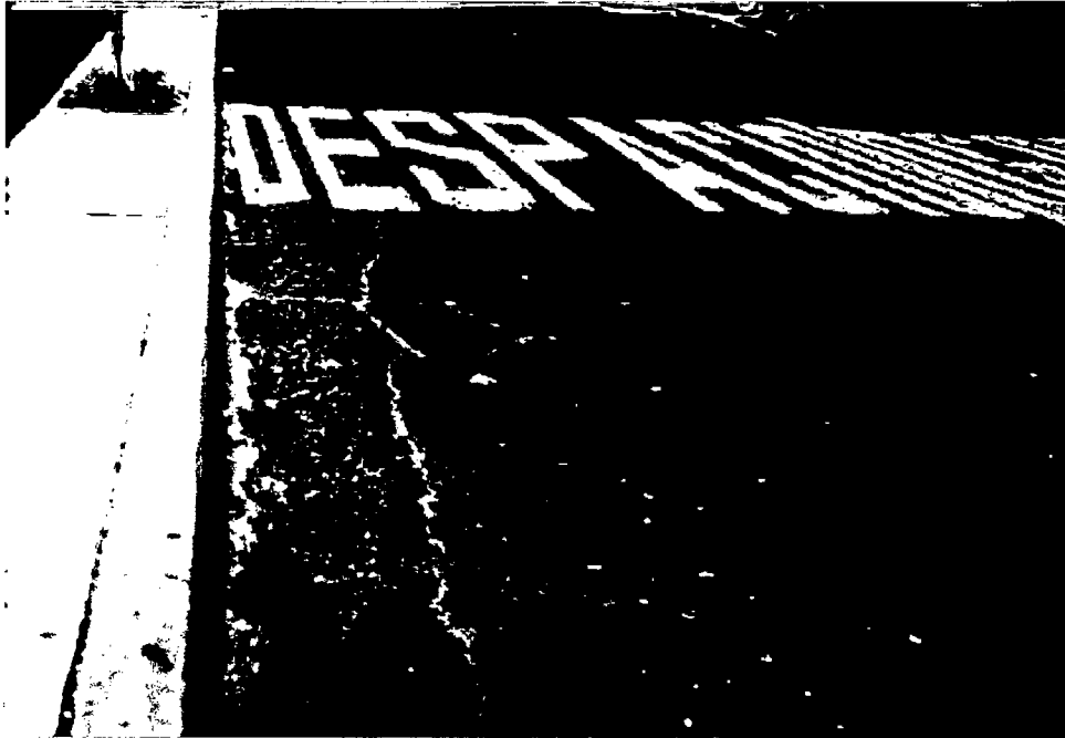
Foto N° 28. Nivel bajo de fisuramiento de borde.
