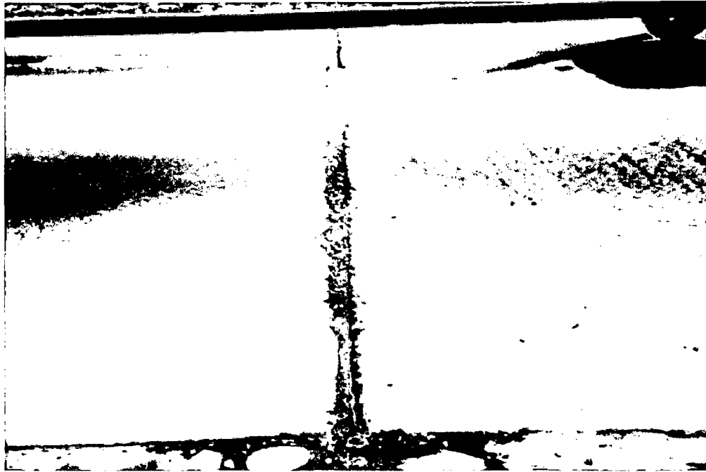
Foto N° 73. Nivel alto de falla de sello de juntas.
