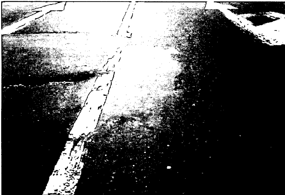
Foto N° 6. Nivel alto de exudación.
