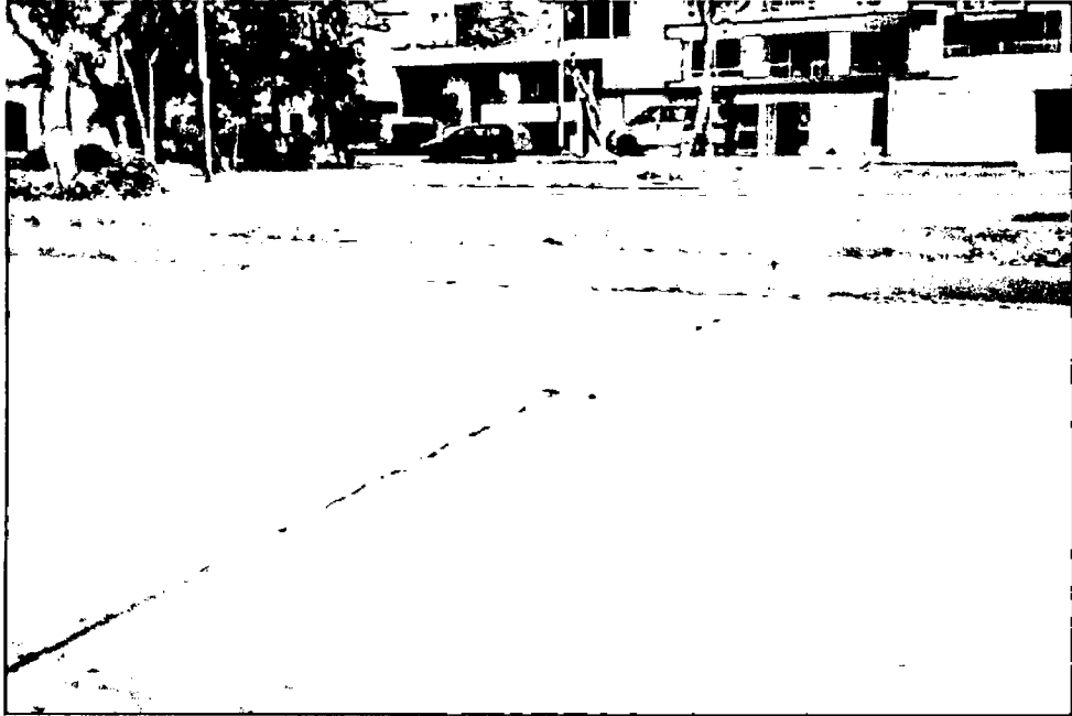
Foto N° 53. Nivel bajo de dislocamiento.
