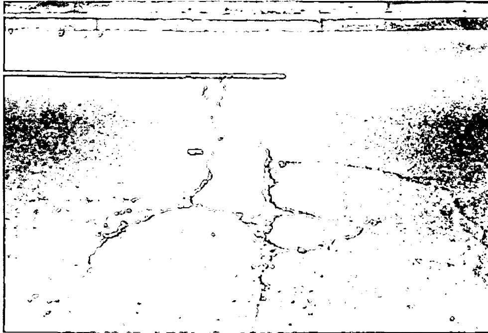
Foto N° 64. Nivel alto de fisuramiento transversal.
