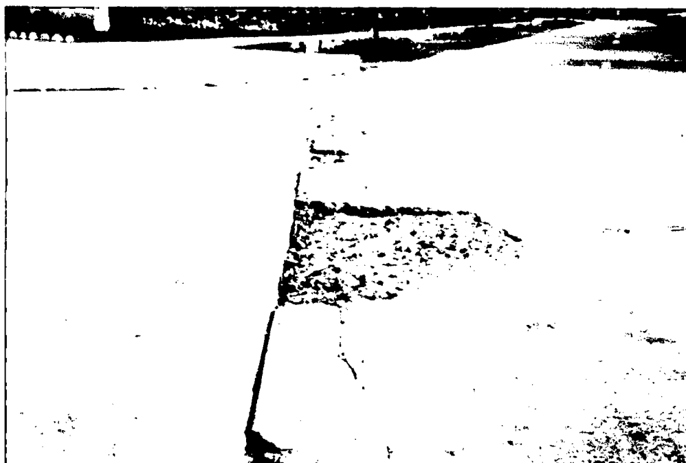
Foto N° 75. Nivel moderado de despostillamiento de juntas.
