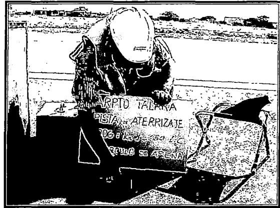
Ejecución de ensayos de macrotextura Círculo de arena
