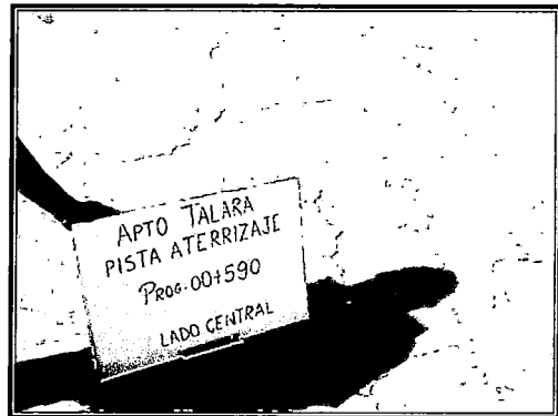
Pista de Aterrizaje. Km 00+590. Parte central. Grietas en bloque y envejecimiento.
