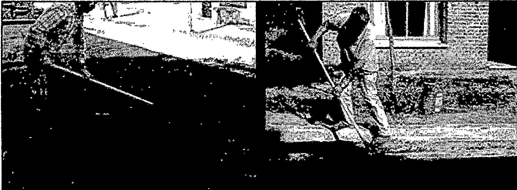
Figura 7.12: Colocación manual del conglomerado calcáreo en las calles de La Plata (Argentina).
