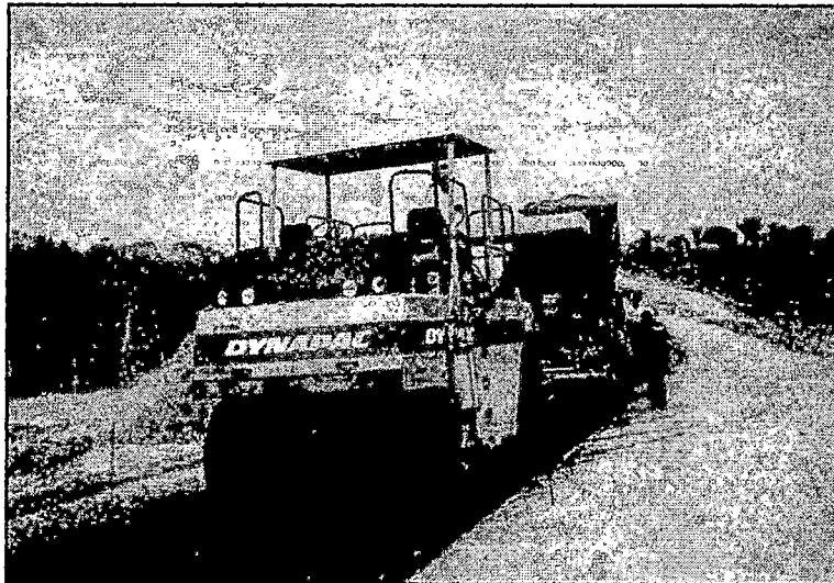
Figura 7.13: Compactación de la mezcla con el rodillo neumático.
