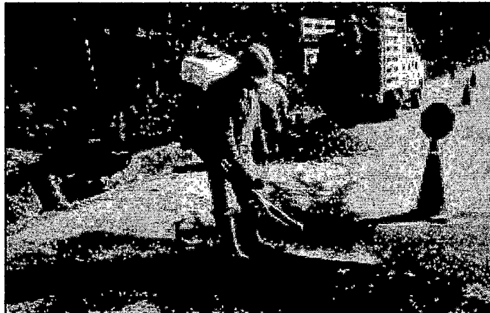
Figura 7.23: Soplado del material con motopulverizadora.
