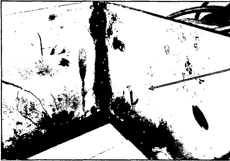
Imagen 77 Esta capa apareció durante todo el mantenimiento del filtro anaerobio por la consistencia se descarta que sea grasa
