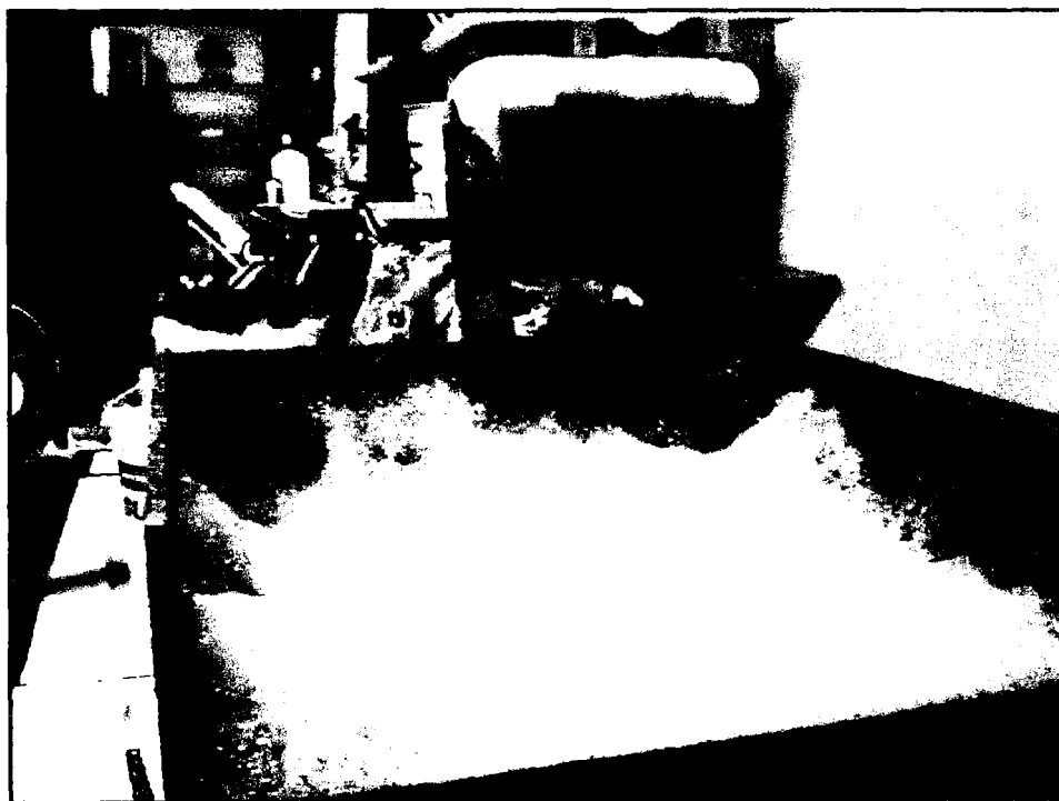
Imagen 64 Generación excesiva de espumas en el filtro
