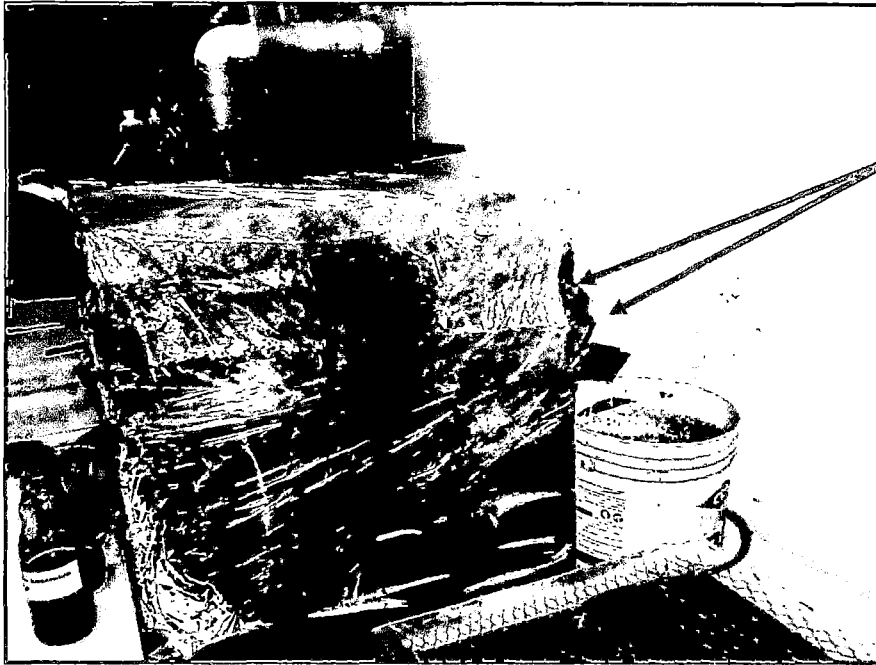
Imagen 69 Se procedió a forrar después de la colocación de la maya notando aun fugas en lugares donde no se había asegurado la maya
