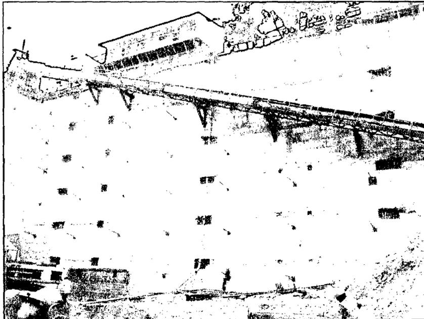
Fotografía 3.7. - Seis niveles de anclajes terminados, 22m de profundidad. Edificio Capital
