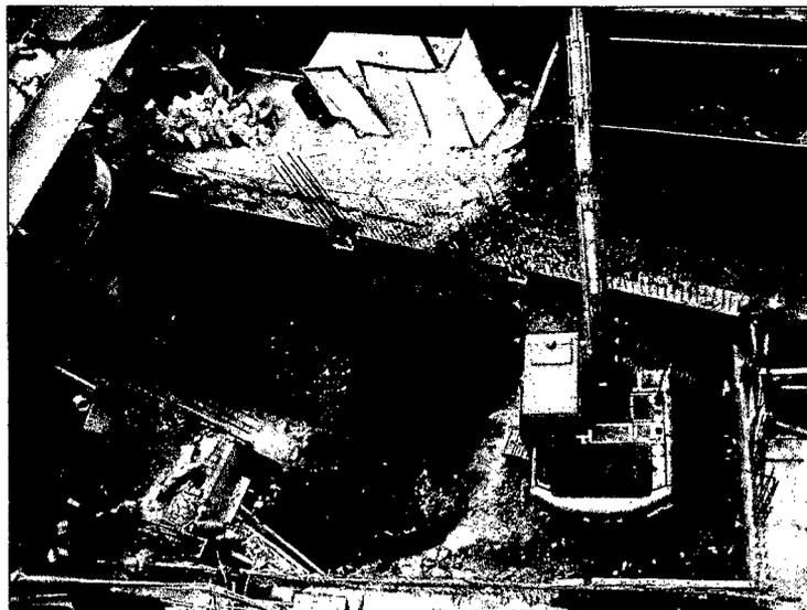
Fotografía 3.20. – Excavación del segundo nivel de soil nailing
