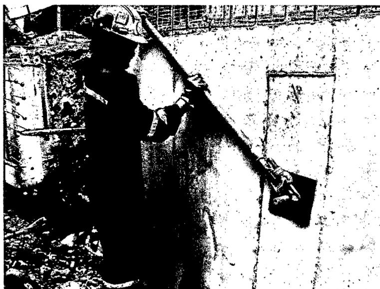
Fotografía 3.18. – Enroscado de la placa del sistema soil nailing
