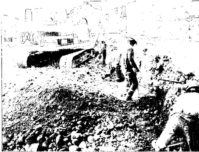
Fotografía 3.15. – Excavación Masiva, observese barras del sistema soil nailing
