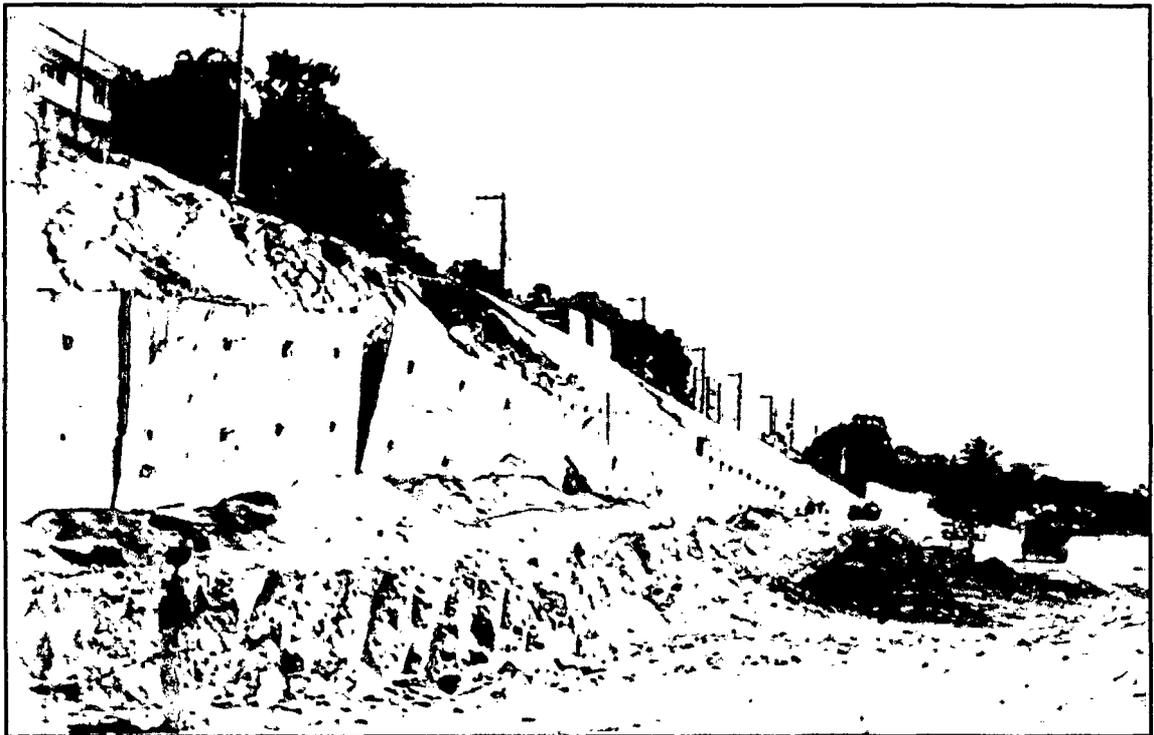
Fotografía 2.9. - Falla de muro anclado durante su construcción. Fuente : Handbook of slope stabilisation J. A. R. Ortigão, Alberto S. F. J. Sayao. Ref(10)
