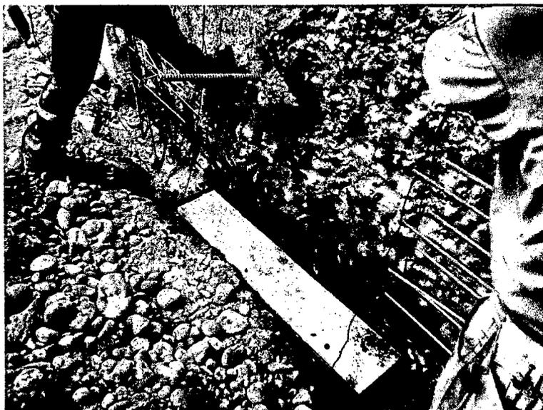
Fotografía 3.17. – Barra de soil nailing obsérvese el bulbo desde un inicio
