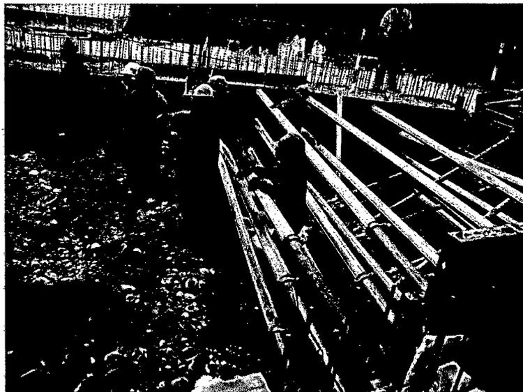
Fotografía 3.22. – Entibado para colocar concreto en el muro trasero
