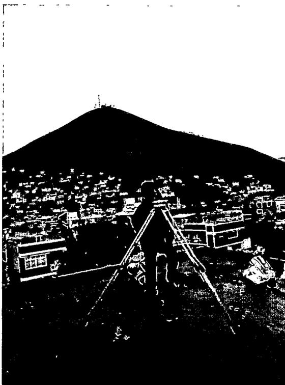
Fotografía D. 3. Nivelación de la plataforma (tribaquio) y ajuste de los tornillos.
