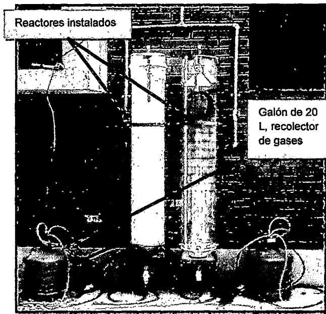
Figura 4.16 Vista de reactores instalados, se observa el sistema de tratamiento con reactores UASB utilizado.
