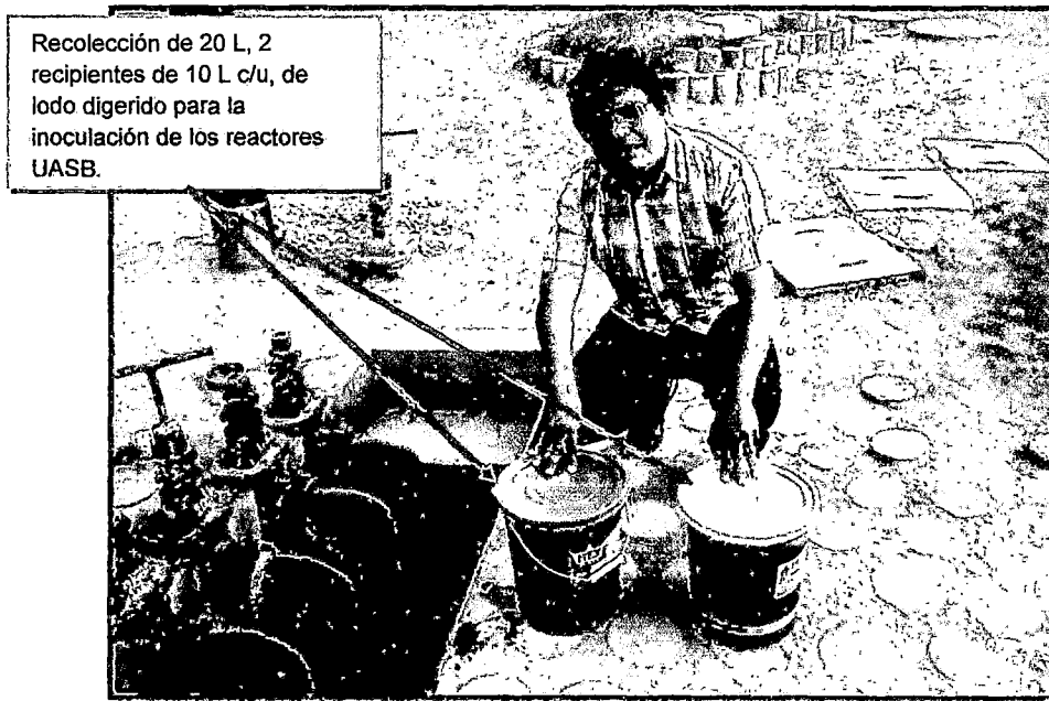
Figura 4.19 Vista del lodo digerido del RAFA de UNITRAR, 40 L de lodo digerido la cual se instalaron en los reactores para empezar el proceso de arranque y tratamiento del afluente.
