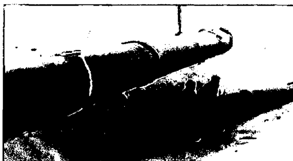
Fig.3.5 Empalmes de las tuberías ERFV
