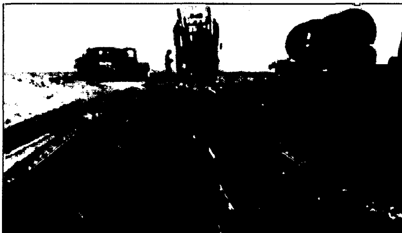
Fig.3.2: Tendido de Tubería ERFV, para el transporte de Hidrocarburos
