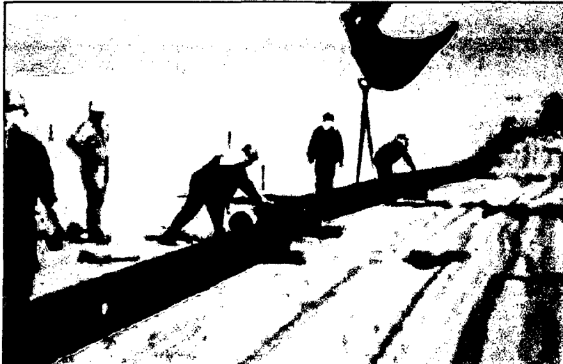
Fig.3.2: Tendido de Tubería ERFV, para el transporte de Hidrocarburos
