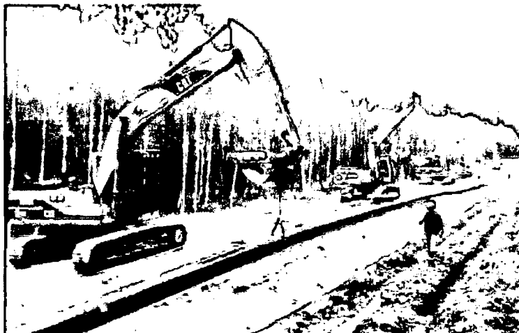
Fig.4.4 Descenso de secciones de tuberías (cuerdas cortas) Utilizando 4 excavadoras con eslingas de nylon
