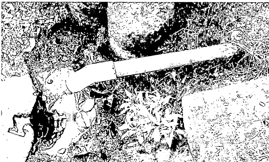
Foto 14. Tubería de salida del efluente del FLA piloto
