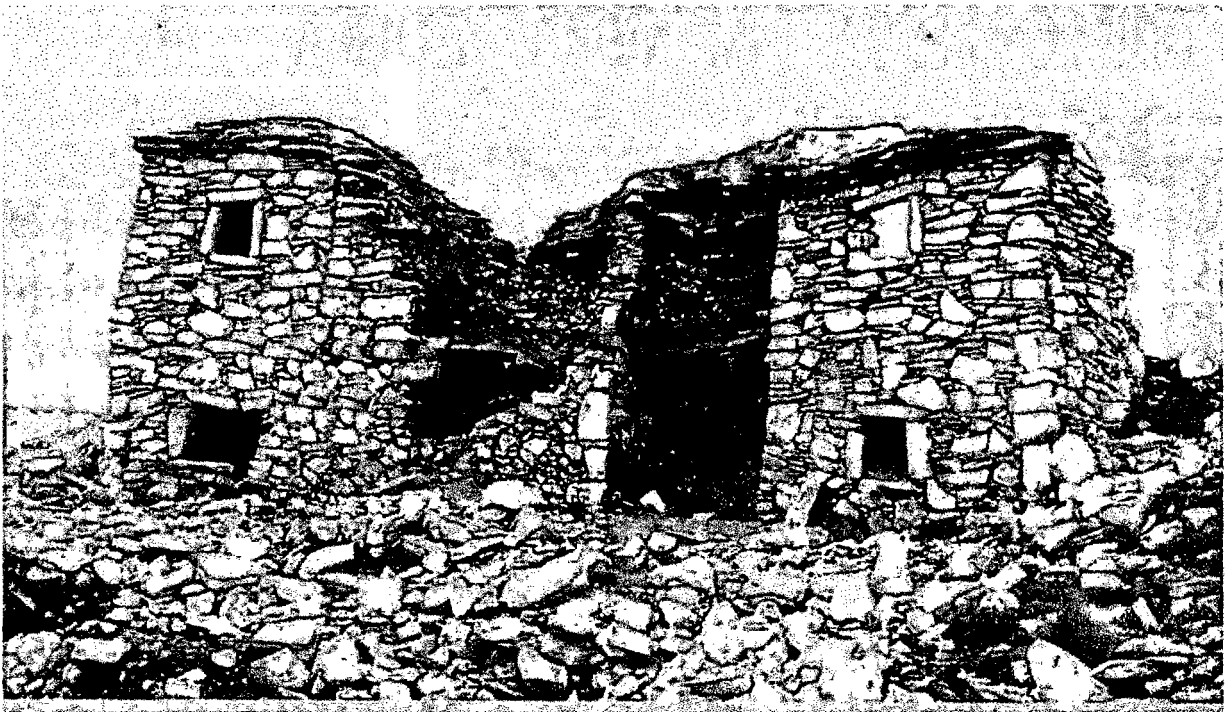
Figura 63. Testimonio arqueológico de una vivienda de dos niveles del antiguo poblador de La Oroya, ubicado en las partes altas de la zona de Huaynacancha.
