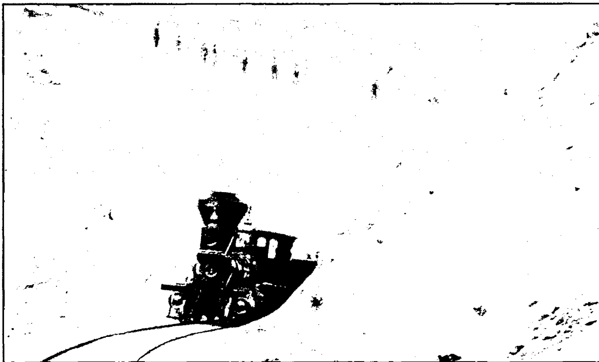
Figura 46. La construcción del ferrocarril central se reinició gracias al contrato Grace a inicios del siglo XX, reactivó el flujo productivo comercial de la minería andina.
