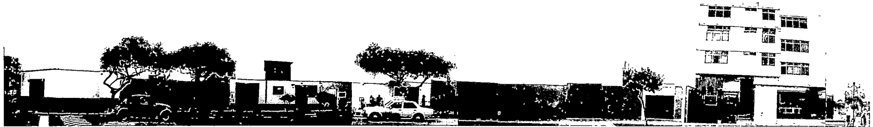
Figura 31. Levantamiento fotográfico Av. Federico Villareal.
