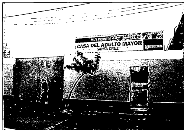
Figura 11. Vista de fachada del predio 4.
