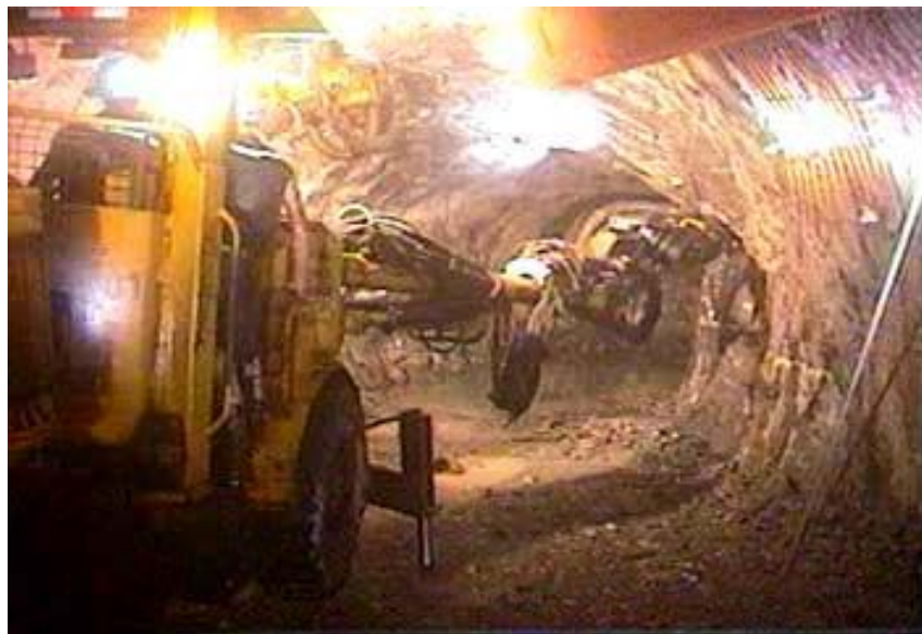
Figura 3: Perforación con Jumbo Rokat Boomer 282 de Rampa 523.
