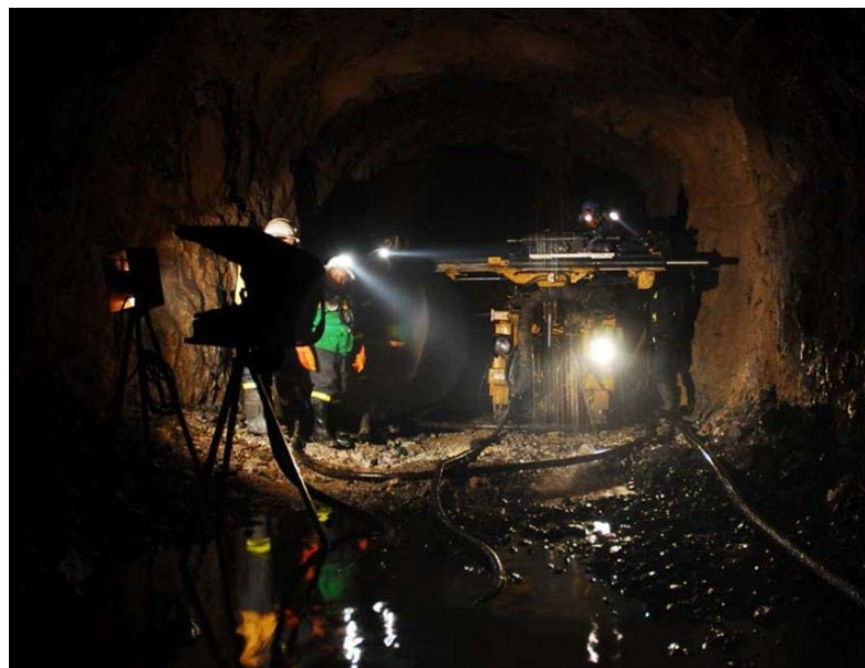
Figura 6: Perforación de taladros largos con equipo Raptor.
