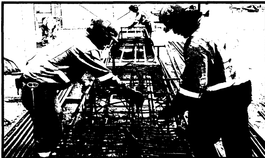
Fig. 4.5: Pre-armado de Elementos Estructurales (Gran Teatro Nacional, GyM S.A.)
