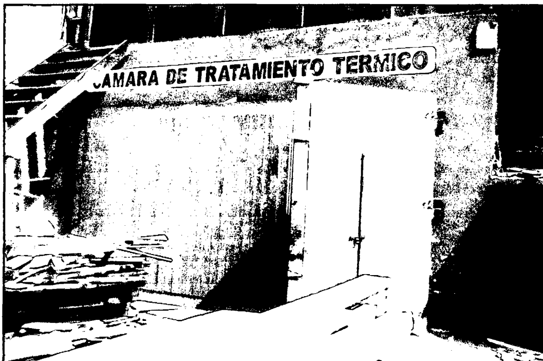
Foto N°11: El secado artificial de las vigas de madera Ojé renaco se realizaron en una "cámara de tratamiento térmico"
