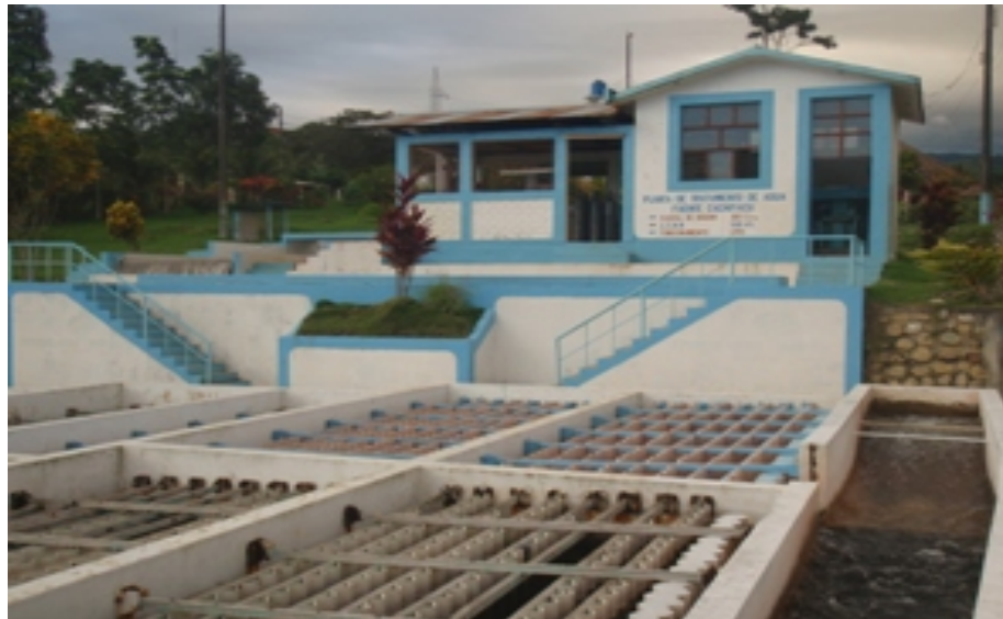
Fotografía 1.3: Planta de Tratamiento Cachiyacu perteneciente a EMAPA SAN MARTIN S.A. (Elaboración Propia)
