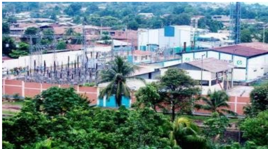
Fotografía 1.4: Planta Termo Eléctrica de ELECTRO ORIENTE S.A. (Elaboración Propia)
