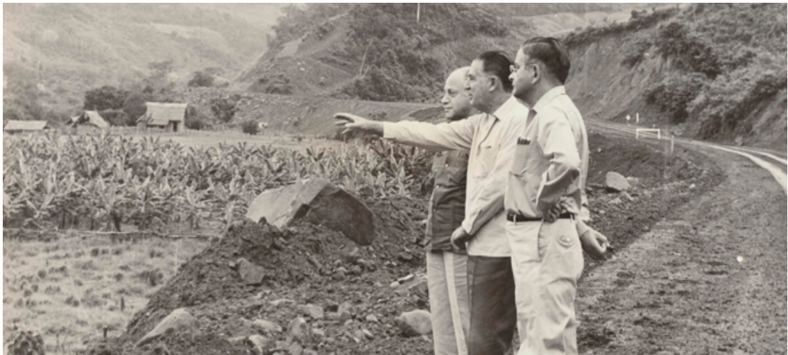
Fotografía 1.1: Construcción de la Carretera Marginal de la Selva Año 1966 (Fuente http://fernandobelaundeterry.com.pe/ )
