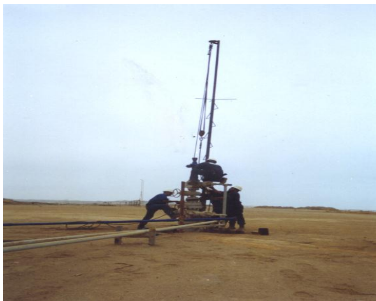
Terminando de armar la unidad de Slickline
